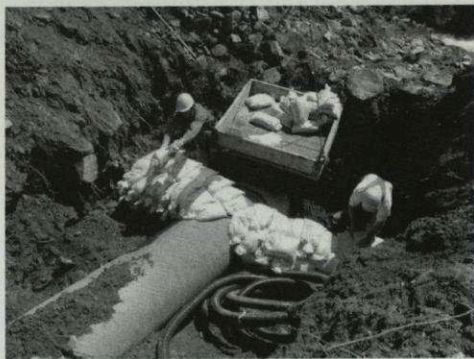
Abbildung 8 Einbau von Sandsackbarrieren
