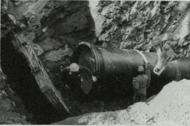
Abbildung 4 Steilhangeinbau DN 1600 im Fels
