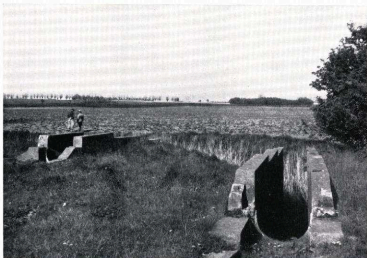
Abb. 36. DuEV Grube-Wessek, Kreis Oldenburg, Gem. Rosenfelde nördl. Dahme; Betonfundamente für Wasserschnecken von zwei ehemaligen Schöpfanlagen der Rosenhöfer Mühle am ehemaligen Gruber See, Rosenhöfer Teil Aufn. KANNENBERG, 1959
