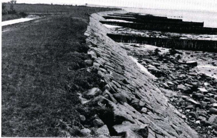
Abb. 10. WuBV Ohrfeld-Koppelheck, Geltinger Bucht, Kreis Flensburg; Deich östlich Hunhoi mit Böschungsdeckwerk und Holzpfahlbuhnen
