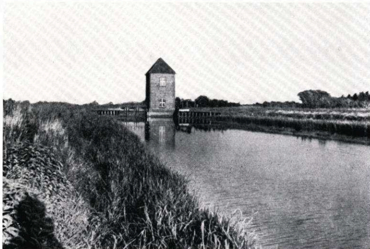
Abb. 39. DuEV Grube-Wessek, Kreis Oldenburg; Schöpfwerk bei Weißenhaus an der Hohwacher Bucht, im Vordergrund bedeckter Hauptvorfluter (Oldenburger Graben) Aufn. WOHLBERG, 1959
