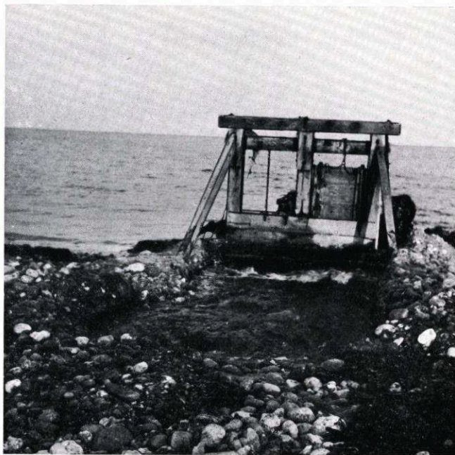
Abb. 32. DuEV Kembs-Behrendorf, Hohwachter Bucht, Kreis Plön; Vorstrandsiel nach dem Hochwasser am 4. Januar 1954 Aufn. LOYAL, 6. Jan. 1954
