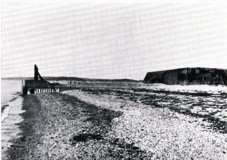
Abb. 24. DuEV Grube-Wessek, Kreis Oldenburg; Sielanlagen bei Weißenhaus: rechts die Betonumwallung des Außenkanals, links das gedeckte Vorstrandsiel Aufn. WOHLBERG, 1959
