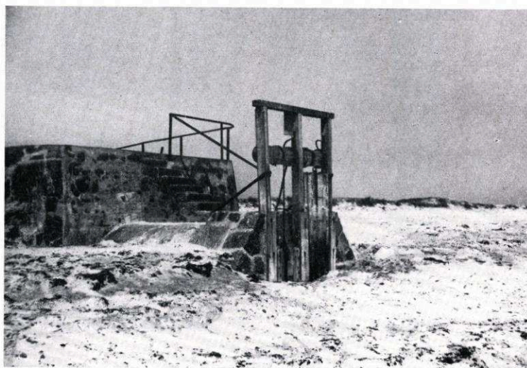
Abb. 30. Klostersee-Niederung, Kreis Oldenburg; Versandetes Vorstrandsiel der Klostersee-Sielanlage. Aufn. KANNENBERG 15. Mai 1959
