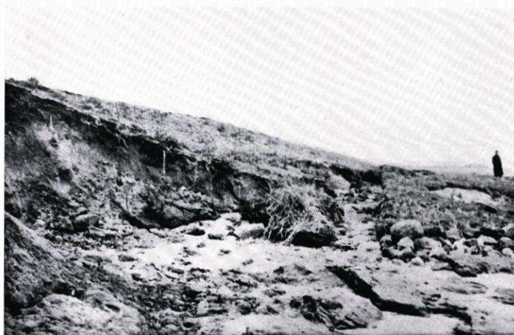
Abb. 11. WuBV Wackerballig, Geltinger Bucht, Kreis Flensburg; Deichschäden nach dem Hochwasser am 2. März 1949. Pegelstand 618 = 125 cm über dem Mittelwasser der Ostsee. Der Deich wurde durch diese Sturmflut (aus NO) fast restlos zerstört
