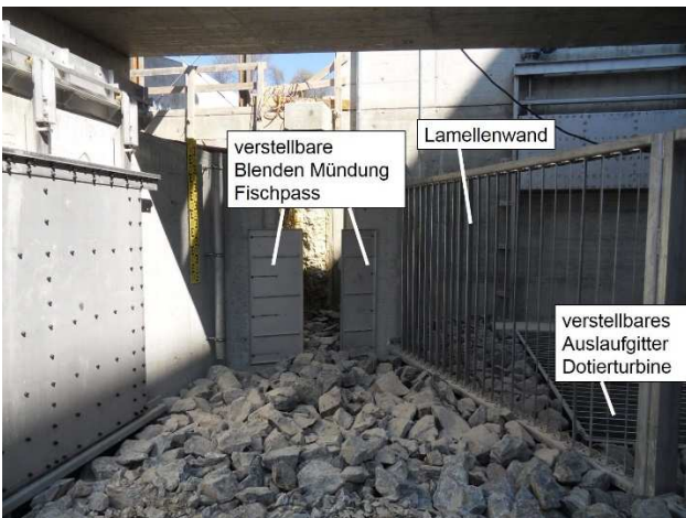
Bild 12: Verstellbare Blenden zur Anpassung des Mündungsquerschnittes des Fischpasses
