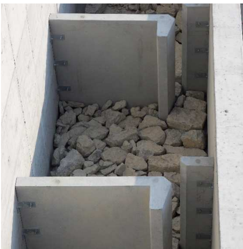
Bild 3: Einbauten aus Fertigteilen Befestigung mit Winkeln
