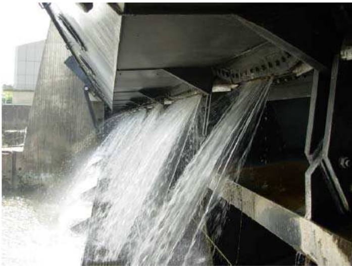
Bild 4: Defekte Klappendichtung
