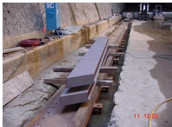
Bild 10: Eingebaute Grundschiene mit nicht eingebauten, Laufschiene
