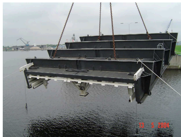
Bild 7: Einbau des Tunnelsegments 3
