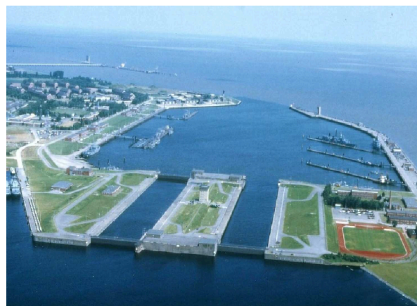
Bild 1: Neuer Vorhafen im Stützpunkt Heppenser Groden mit Seeschleuse
