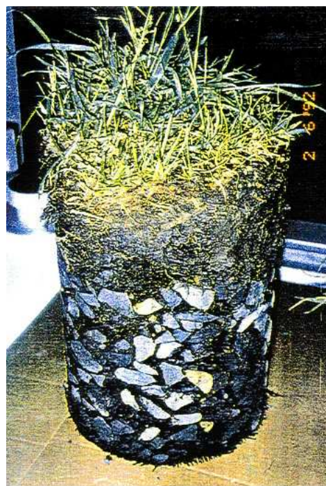
Bild 15.2: Bohrkern aus einem Deckwerk aus Mastix-Schotter mit aufgebrachter Humusschicht und Begrünung :/Elskens 1995/
