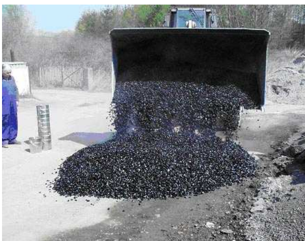
Bild 15.10: Einstellung des Mischwerkes mittels Probemischungen nach erfolgter Eignungsprüfung
