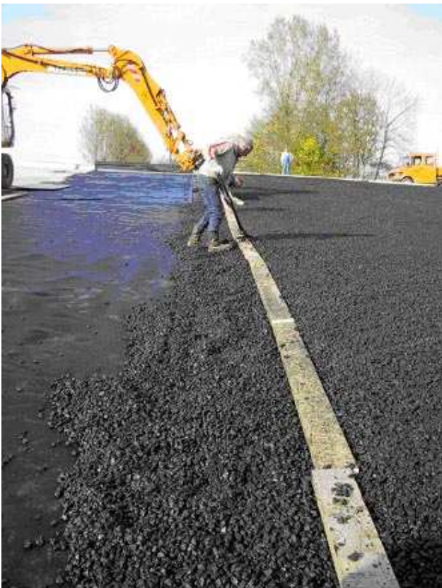
Bild 15.18: Herstellung einer Arbeitsfuge in Falllinie mittels Kantholz
