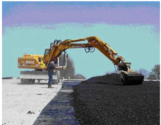
Bild 15.15: Verteilen und Andrücken des Mischgutes
