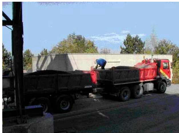
Bild 15.11: Beladung der LKWs im Mischwerk und Abdecken des Mischgutes zur Gewährleistung der Einbautemperatur von 110 bis 140°C
