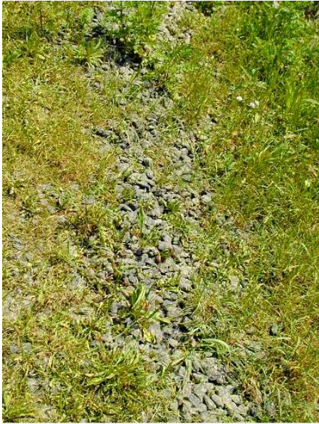
Bild 15.3: Begrünung eines Deckwerkes aus Mastix-Schotter durch natürlichen Samenflug
