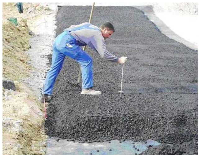
Bild 15.16: Kontrolle der Deckwerksstärke
