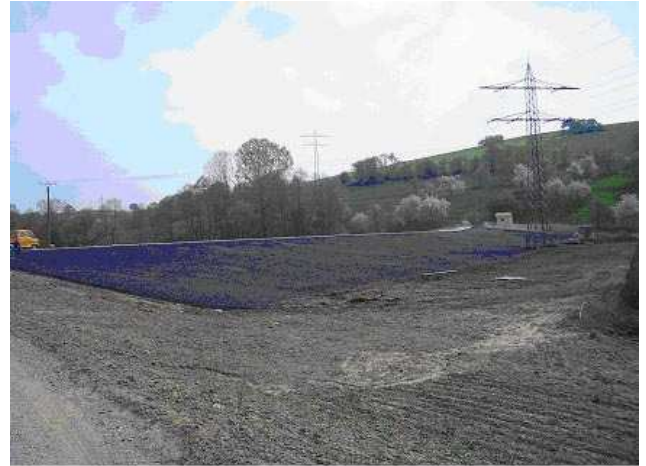
Bild 15.19: Deckwerk nach Abschluß des Einbaus des Mastix-Schotters
