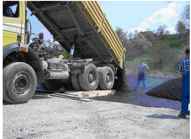
Bild 15.14: Abladen des Mischgutes ohne direkte Befahrung des Geogewebes
