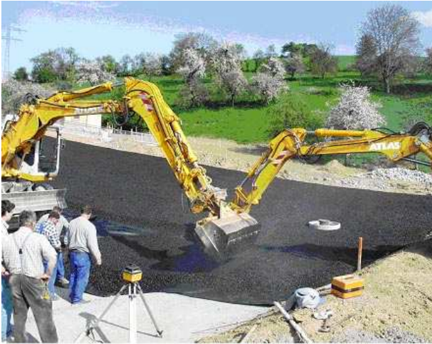
Bild 15.17: Ausformung des Kolkbereiches am luftseitigen Böschungsfuß sowie Durchführung eines Schachtanschlusses
