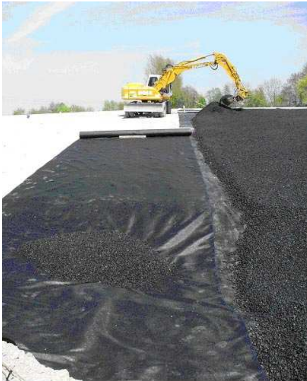
Bild 15.12: Verlegung des filterfesten Geogewebes mit Mindestüberlappung auf dem ausreichend tragfähigen Planum
