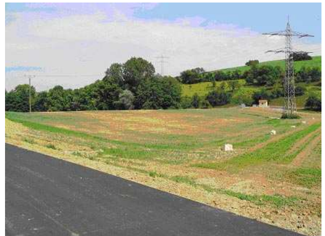
Bild 15.20: Überströmstrecke nach Auftrag des Oberbodens und Einsaat
