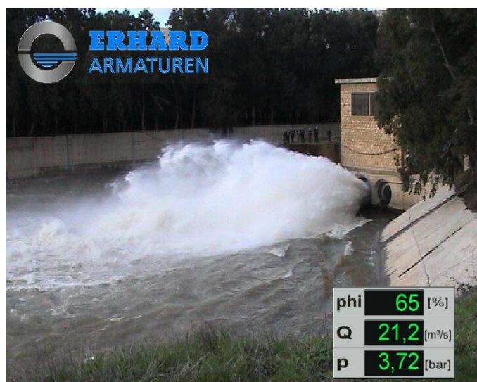
Abb. 1: Ringkolbenschieber (RKS) DN 1800 als GA-Armatur
