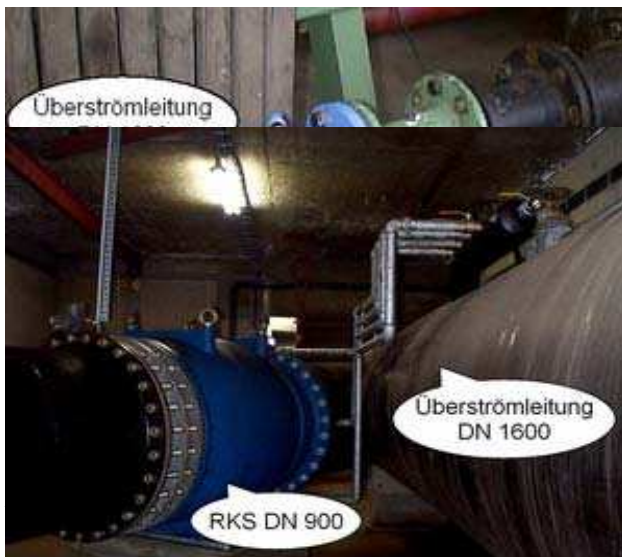
Abb. 9: Originalanlage RKS DN 900
