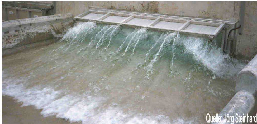
Abbildung 1 Spülwelle in einem Regenüberlaufbecken (Foto: Steinhardt Wassertechnik).
