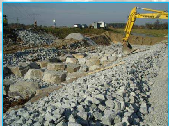
Schwarze Elster - Umbau Köhlerwehr
