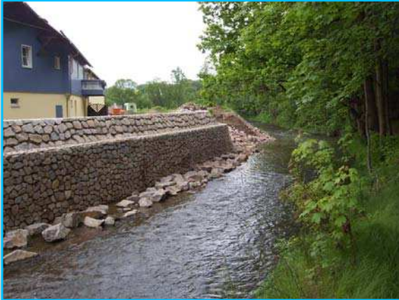
Hochwasserschutz "Große Striegis" Landkreis Mittweida: Ufersicherung
