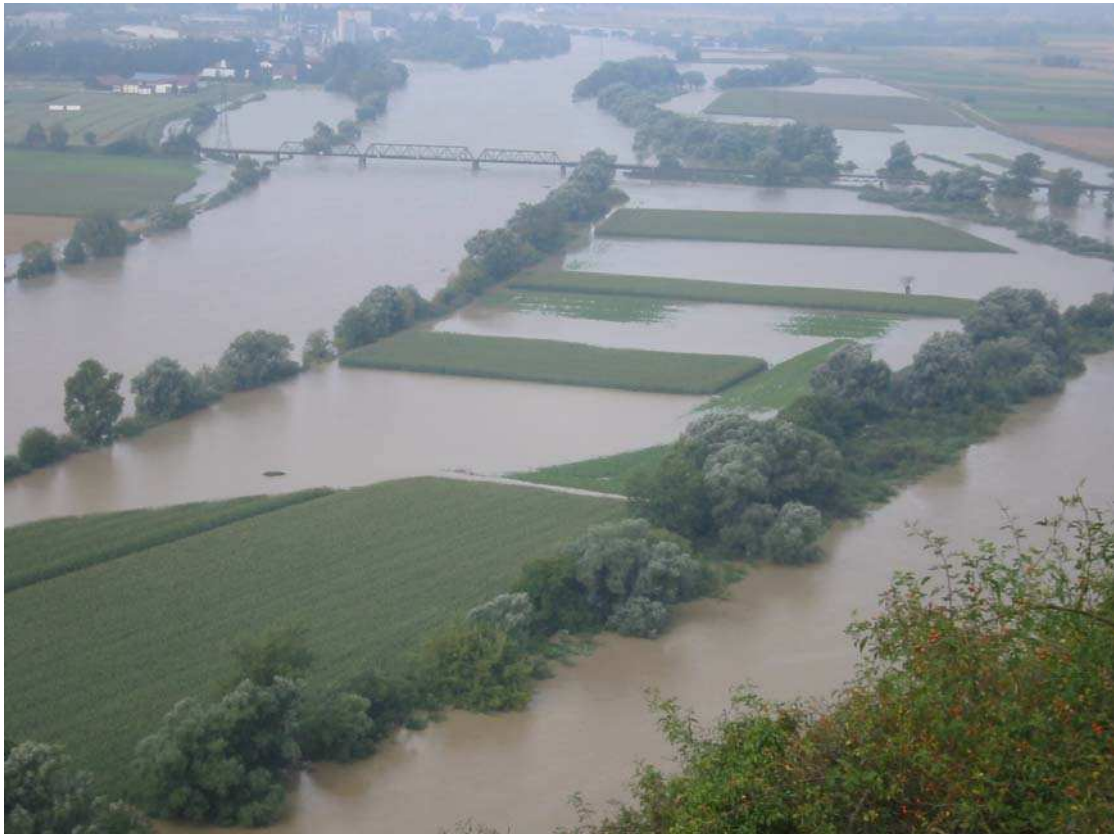
Abbildung 5 Hochwasser im August 2005, Bogener Insel in Richtung Oberstrom
