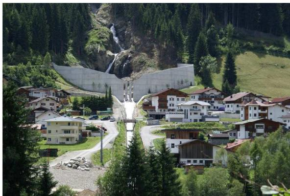
**Abbildung 2:** Fertiggestelltes Rückhaltebecken und Unterlaufgerinne (Bildquelle: Wildbach- und Lawinerverbauung 2015)
