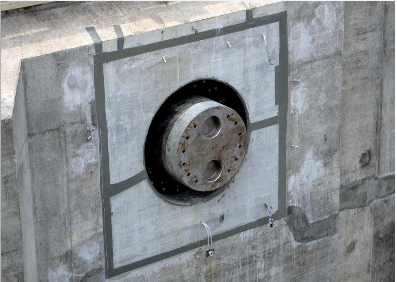
Bild 2: Drehsegmenttorlager nach dem Zweitbetoneinbau
