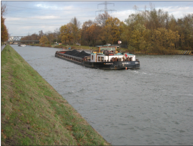
Bild 2.5: Noch nicht ausgebauter Streckenbereich, RHK Los 6 Figure 2.5: RHK reach before development, lot 6
