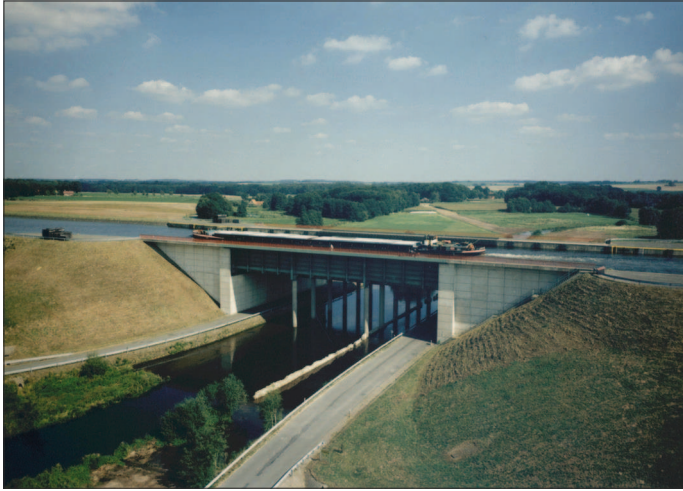
Bild 2.7: Kanalbrücke Ilmenau-Nord am Elbe-Seitenkanal (Foto: WSA Uelzen)
