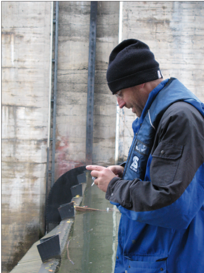
Bild 1.5: Probeinstandsetzung mit Textilbeton am Wehr Horkheim (Neckar)
