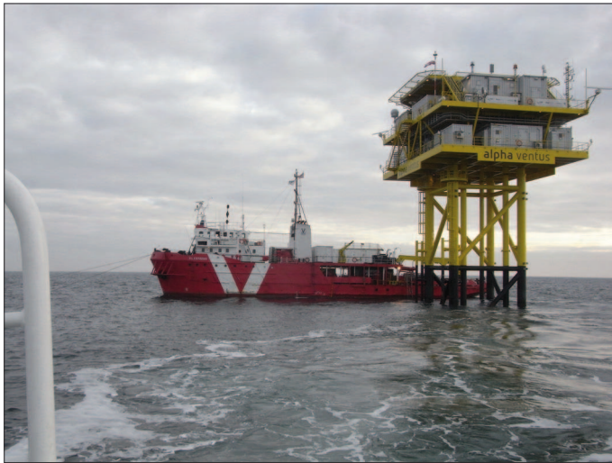
Bild 1.3 Gründungsstruktur des Umspannwerks Windpark alpha ventus (Nordsee)
