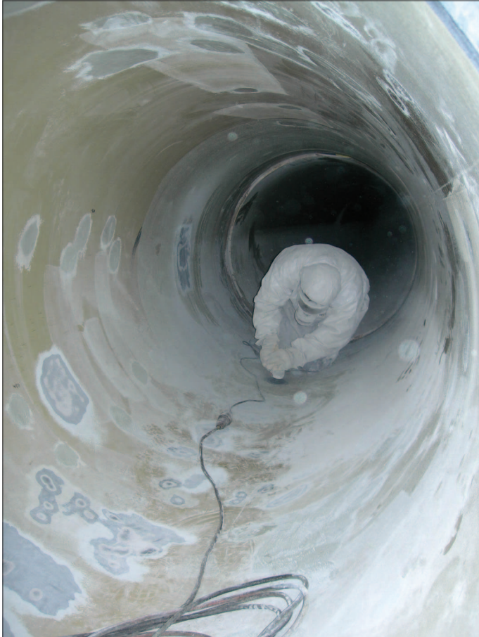
Bild 1.6: Instandsetzung des Korrosionsschutzes am Grundablass der Edertalsperre
