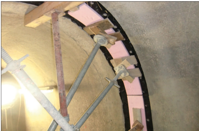
Bild 1.4: Instandsetzung von Bewegungsfugen mit SBK an der Schleuse Kleinostheim (Main)
