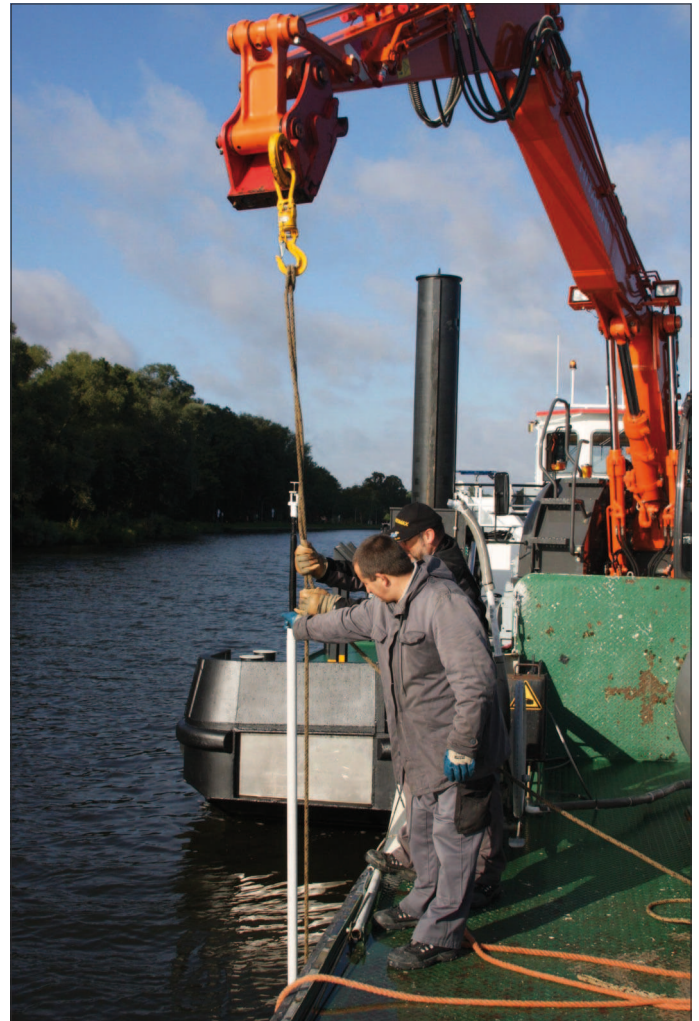
Bild 2.6: FreezeCore-Einsatz an der Havel - Arbeiten vom Ponton aus
