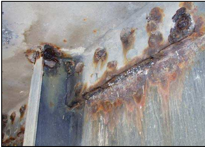
Bild 4: Spaltkorrosion (aus "Online-Hilfe zur Unterstützung der Schadensqualifizierung bei der Bauwerksprüfung" WSV-Pruf)
