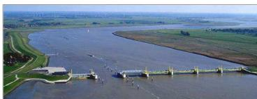
Ein Sturmflutsperrwerk im Mündungsbereich von z. B. Weser oder Ems schützt den stromauf des Sperrwerkes gelegenen Bereich auch bei einem Meeresspiegelanstieg von 80 cm vor Sturmfluten. Die Schutzfunktion bleibt auch bei Sturmfluten mit hohem Oberwasserzufluss erhalten. Bei extrem hohem Meeresspiegelanstieg, hier msl + 200 cm, versagt die Schutzfunktion des Sperrwerkes.
