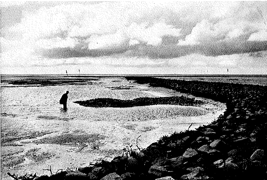
Abb. 23. Tiefgehende Wattabtragungen im Süden der mit Steinbelag beschwerten Buschmatte zur Sicherung des Dammkopfes.
