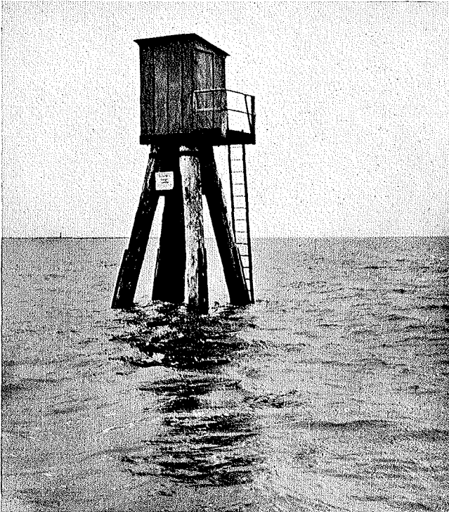
Abb. 9. Schreibpegel Trischen auf neu errichtetem Dalben am neuen Standort im Neu- fahrwasser. Im Hinter- grund die Insel Trischen mit Bake. Bildarchiv Westküste B — b XLIV, 26 Aufn. E.G.Haberstroh, 12.Feb.1937
