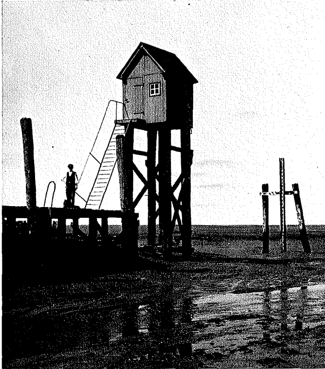
Abb. 8. Alter Schreibpegel Trischen am bisherigen Standort im Hafenpriel bei Niedrigwasser. Rechts der alte Lattenpegel. Bildarchiv Westküste B — a 36 25. Juli 1935
