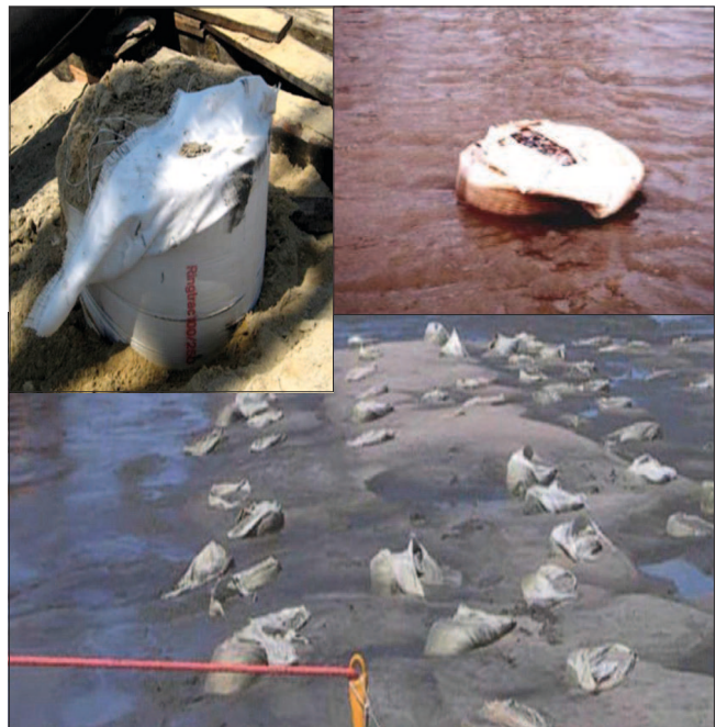
Bild 8: Beispiele ausgeführter GECs: in einer Sandplattform, in fließendem Wasser, im Schluck
