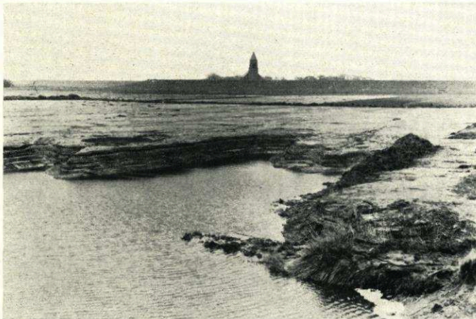
Abb. 13. Blick auf die Wehle im Ülvesbüller Koog. Im Hintergrund der Schlafdeich als zweite Deichlinie mit der Kirche Ülvesbüll Aufn. E. Wohlenberg
