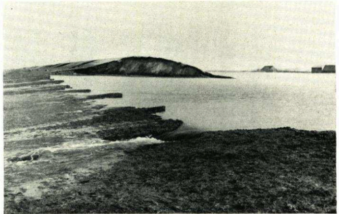
Abb. 19. Das Meer (links) ist inzwischen zurückgetreten, der Koog noch überflutet. Die beim Durch- bruch in voller Breite erhalten gebliebene Berme des Deiches hält das abfließende Wasser im Koog zurück Aufn. E. Wohlenberg
