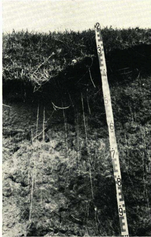
Abb. 6. Die fädigen Wurzeln von Agropyron littorale dringen einzeln 2 m tief in den nährstoffarmen sandig-schluffigen Deichkern, aber die Grasnarbe an der Böschung des Deiches ist schlecht und besitzt keine Abwehrkraft gegenüber dem Wasser Aufn. E. Wohlenberg
