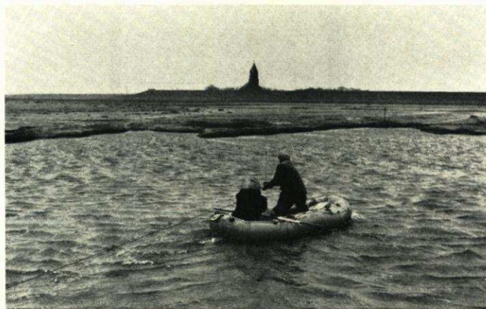
Abb. 29. Die Auslotung der Wehle vor ihrer Verfüllung und Einplanierung Aufn. E. Wohlenberg
