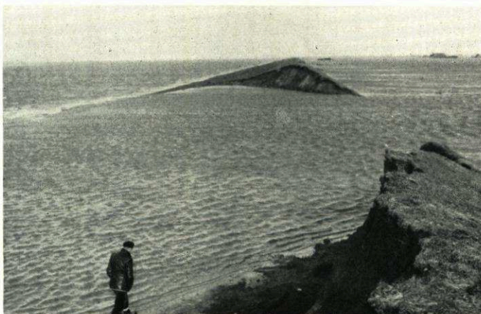
Abb. 11. Der Deichbruch am Morgen nach der Sturmflut. Links die See, rechts der Koog Aufn. E. Wohlenberg
