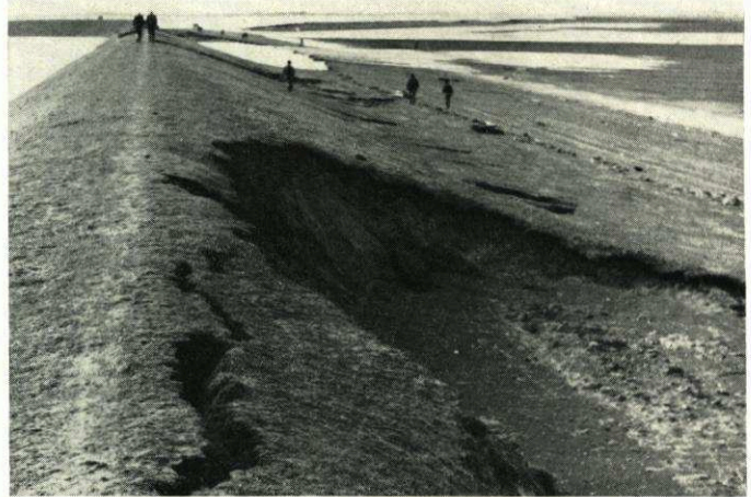
Abb. 7. Seedeich Ülvesbüll nach der Februar-Sturmflut 1962. Ein Teil der Deichkrone stürzt in den steilwandigen Einbruch. Erosionsbasis fast waagrecht Aufn. E. Wohlenberg
