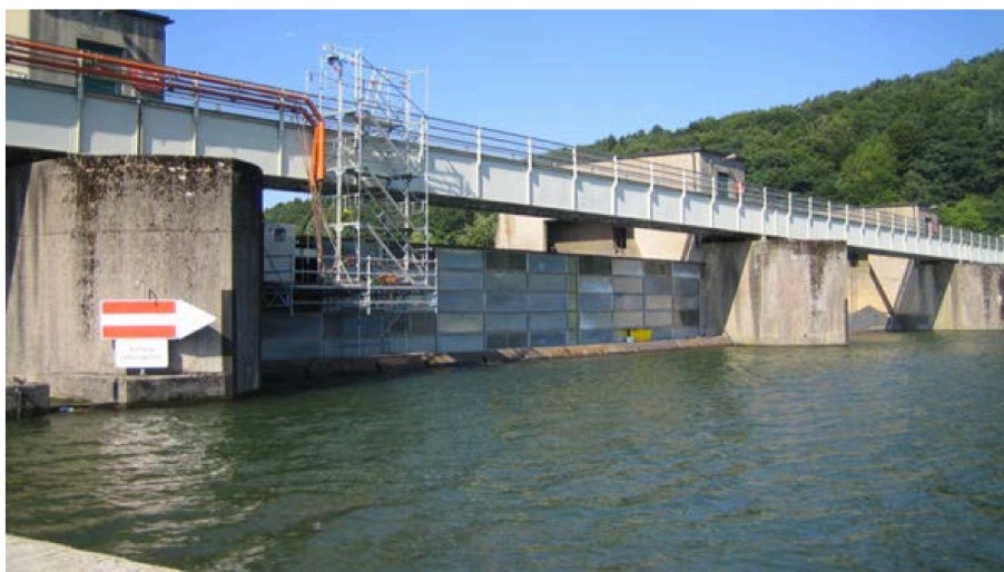
Abbildung 4: Komplettinhausung einer Wehrwalze
