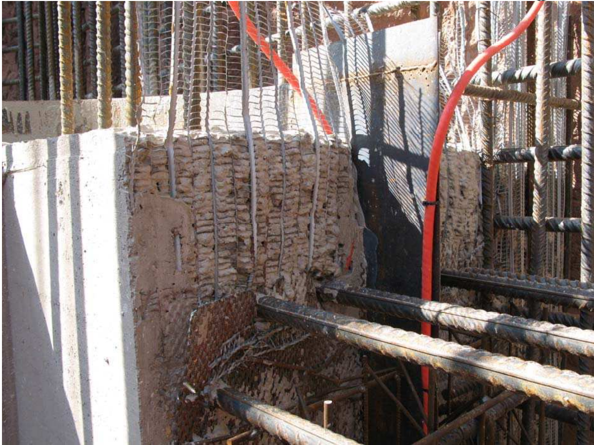
Bild 4: Vertikale Arbeitsfuge mit kritischer Ausführungsqualität
