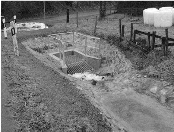
Abbildung 3: Einlauf des Rammsieps zur Straßendurchführung nach Realisierung der Variante 2
