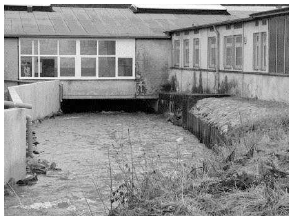
Abbildung 8: Abflussthroughführung unter der Fa. Teckentrup nach Realisierung der Variante 6
