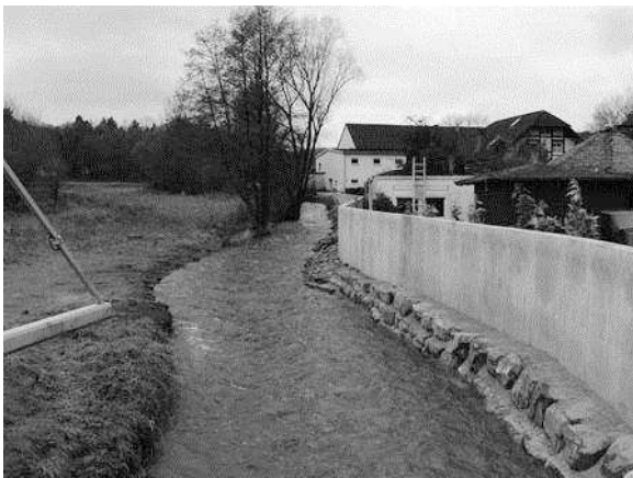
Abbildung 5: Gewässerlauf und Ufer im Bereich der Wohnbebauung vor Maßnahmenrealisierung
