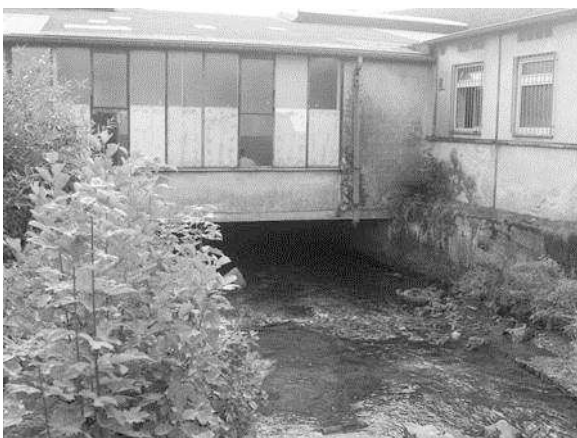
Abbildung 7: Abflussthroughführung unter der Fa. Teckentrup vor der Maßnahmenrealisierung
