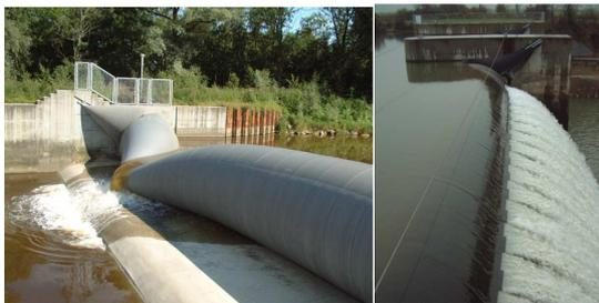
Figure 3: a) «Flambement» du barrage Tuerkheim/Wertach gonflé à l'eau (phénomène de V-notch) b) Barrage de Kiebingen/Neckar gonflé à l'air avec déflecteur
