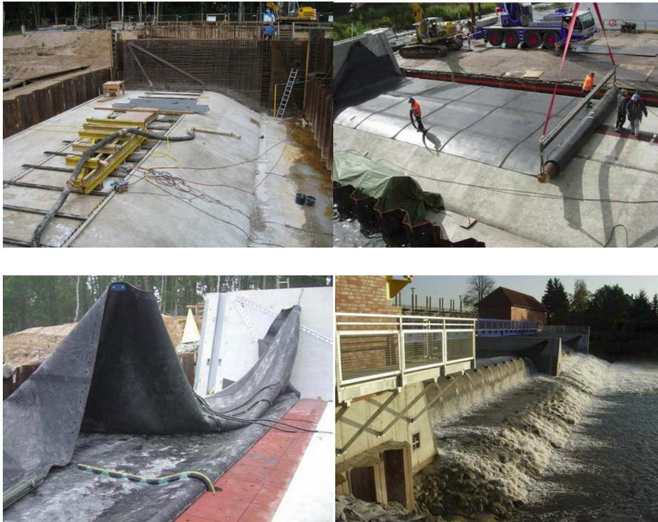
Figure 8: Barrage de Marklendorf sur la rivière Aller a) Génie civil, b) et c) Mise en place de la membrane d) Barrage en fonctionnement
