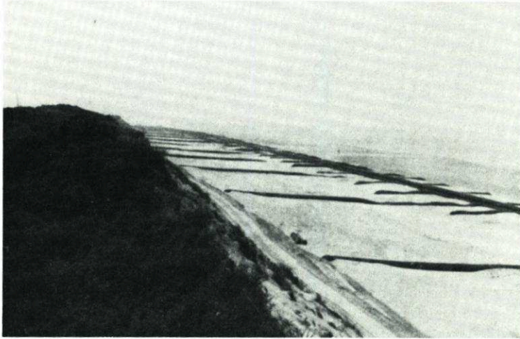
Abb. 9. Das Schlauchwerk auf dem Strand vor der Randdüne des Pirolatals auf Langeoog (Foto: WSA Norden, 28. 9. 1971)
