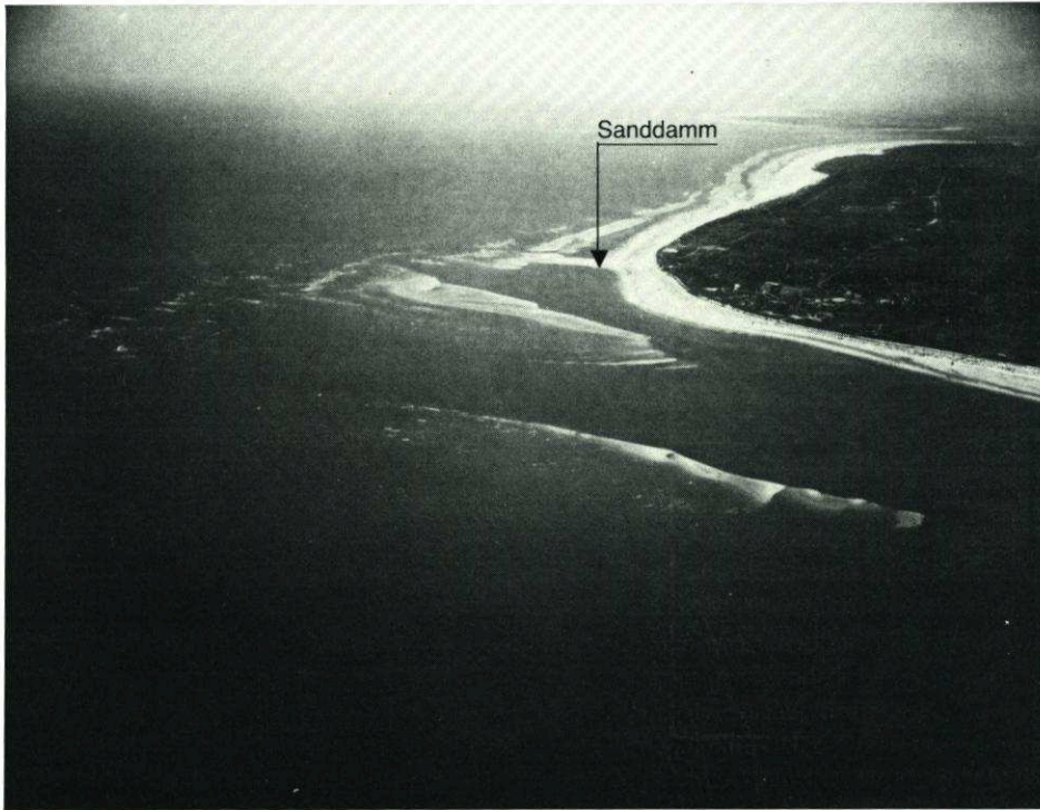
Abb. 10. Blick auf Langeoogs Nordwesten mit sich annähernden Platen und dem neugespülten Sanddamm durch die Strandbalje (Foto: Kolde, Juli 1982, freigegeben d. d. Bez.-Reg. Weser-Ems, Nr. 115/884)
