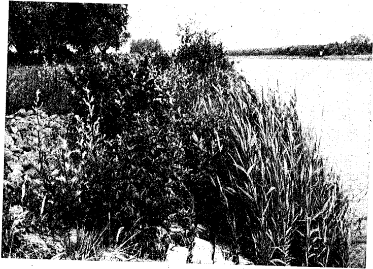
Bild 2: Begrünte Böschung — Böschungsbefestigung aus Beton-Verbundsteinen (TerraFix-Deckwerkssystem)
