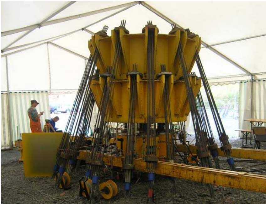
Bild 1: Widerlagerkonstruktion einer statische Pfahlprobelastung
