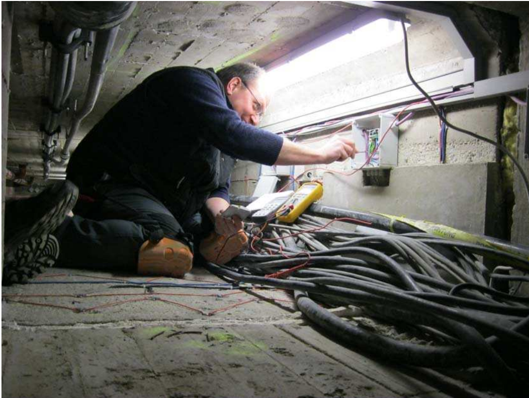
Bild 1: Funktionsprüfung an installierten diskreten Fremdstromanoden
