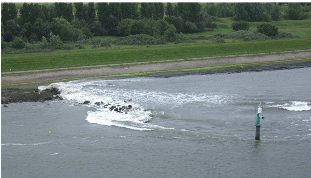
Bild 1: Schiffserzeugte Absenkung und Primärwellenbelastung einer Buhne in einer Seeschiffahrtsstraße
