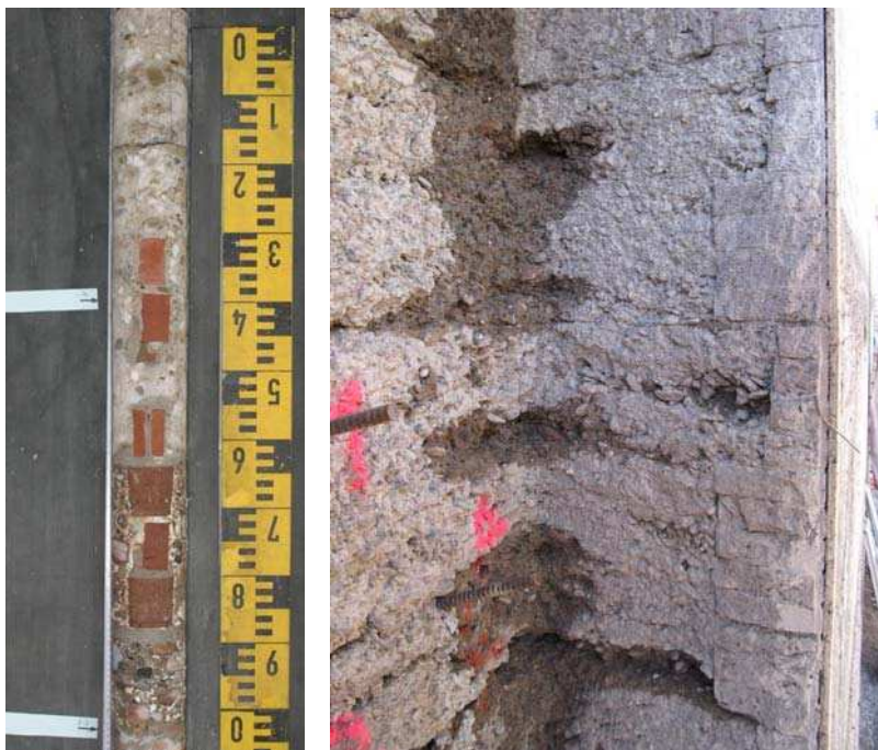
Bild 1: Injizierter Bohrkern (links), Verbund Vorsatzschale-Kernbeton (rechts)
