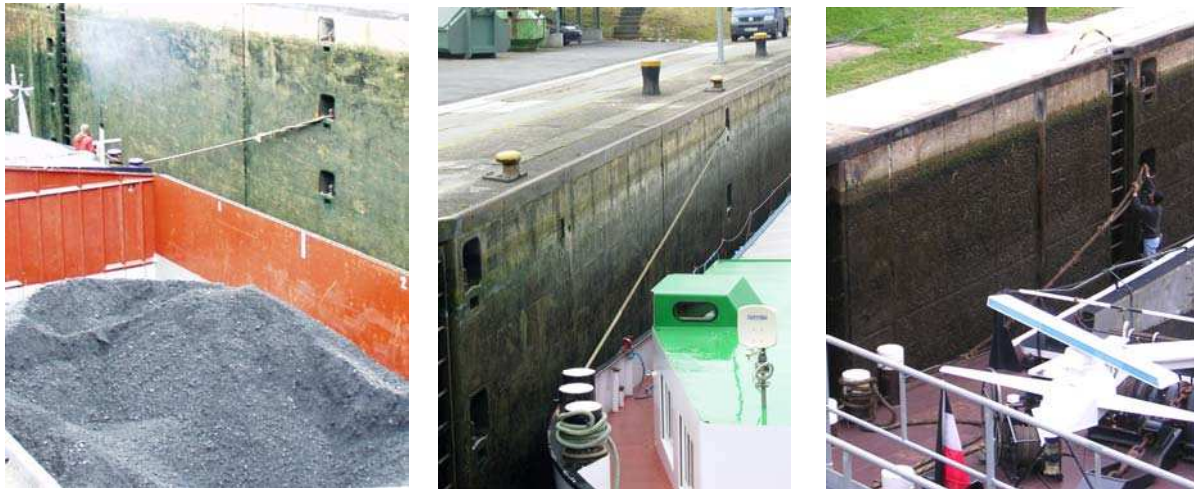
Bild 2: Typische Situationen beim Festmachen, Spannen und Lösen der Trossen an Nischenpollern
