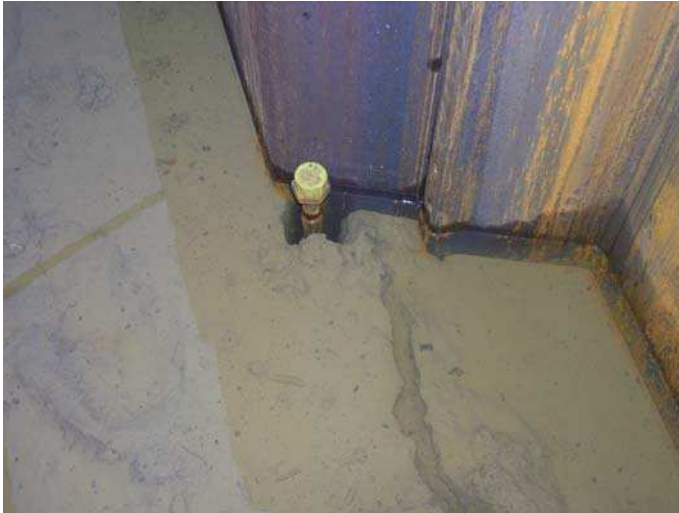
Bild 1: Durchdringung einer Spundwand durch eine Tondichtung
