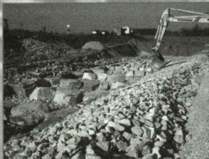
Schwarze Elster - Umbau Köhlerwehr
