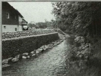
Hochwasserschutz "Große Striegis" Landkreis Mittweida: Ufersicherung
