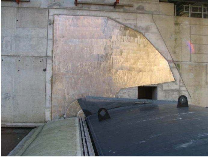
Bild 1: Edelstahlschleiffläche der Seitendichtung an einem Wehr
