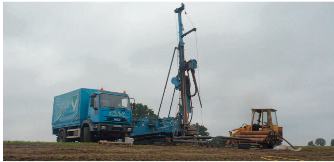
Abb. 4: Einrichtung einer Grundwassermessstelle
