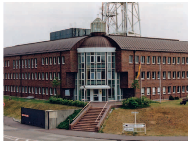
Abb.2: Dienstgebäude WSA Cuxhaven
