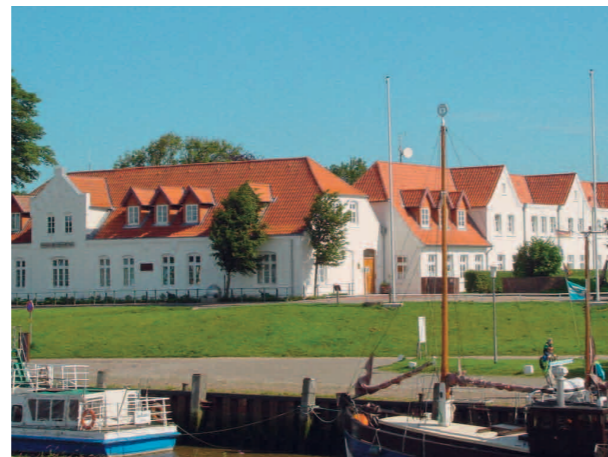
Abb. 1: Dienstgebäude WSA Tönning
