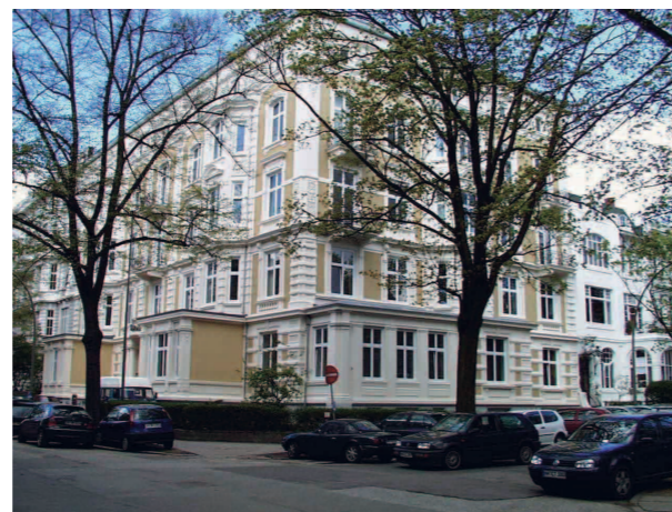
Abb. 1: Dienstgebäude WSA Hamburg
