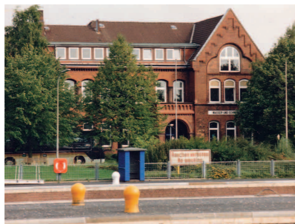
Abb. 2: Dienstgebäude WSA Kiel-Holtenau
