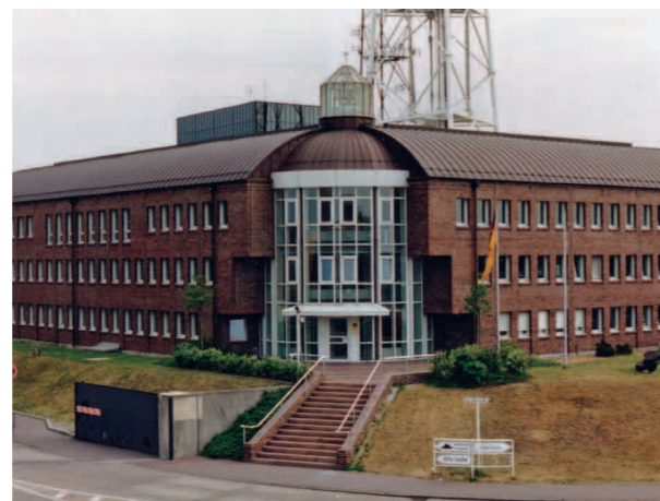
Abb. 2: Dienstgebäude WSA Cuxhaven
