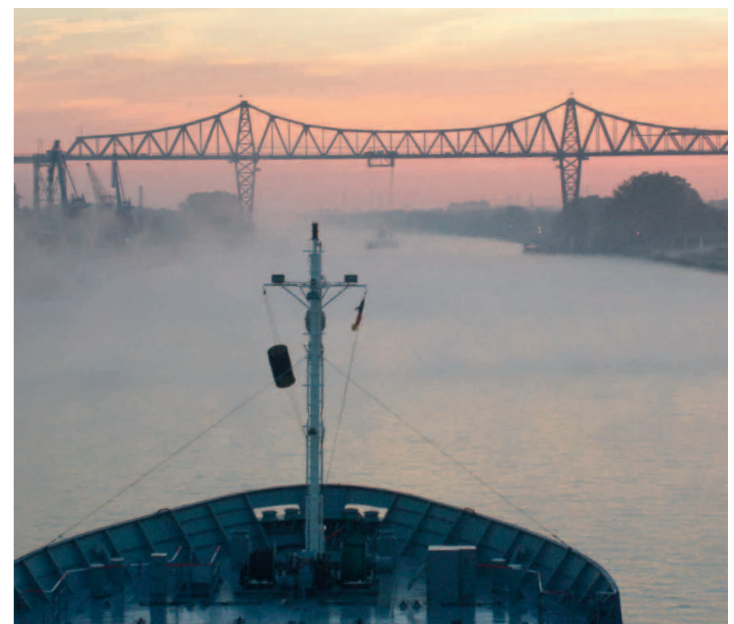
Abb.5: Blick auf die Rendsburger Eisenbahnhochbrücke
