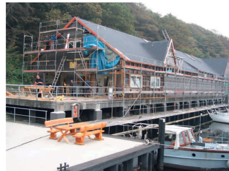
Abb. 3: Instandsetzung der Bootshalle
