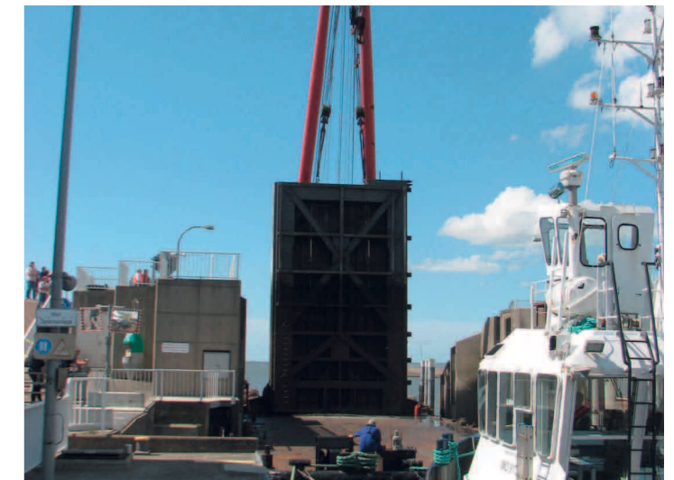
Abb. 4: Sanierte Gleitschiene/Schütz (oben) Abb. 5: Tor 1 beim Einbau (unten)
