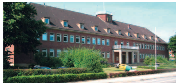
Abb. 1: Dienstgebäude der WSD-Nord
