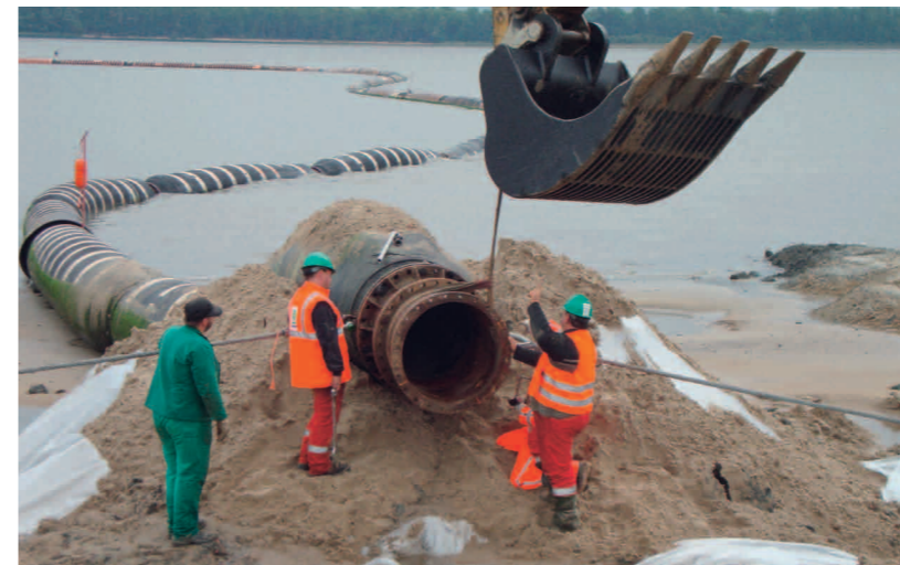
Abb. 2: Schwimmrohrleitung der Vorspülung Grauerort
