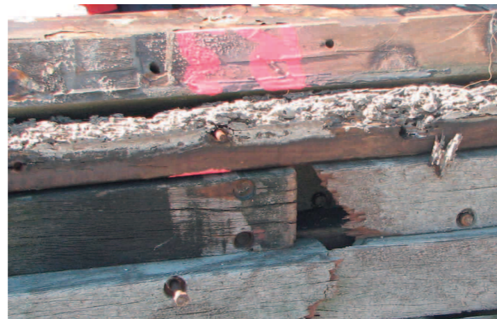
Abb. 2: Ausgebaute Dichthölzer
