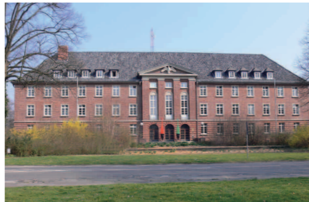
Dienstgebäude WSA Lübeck
