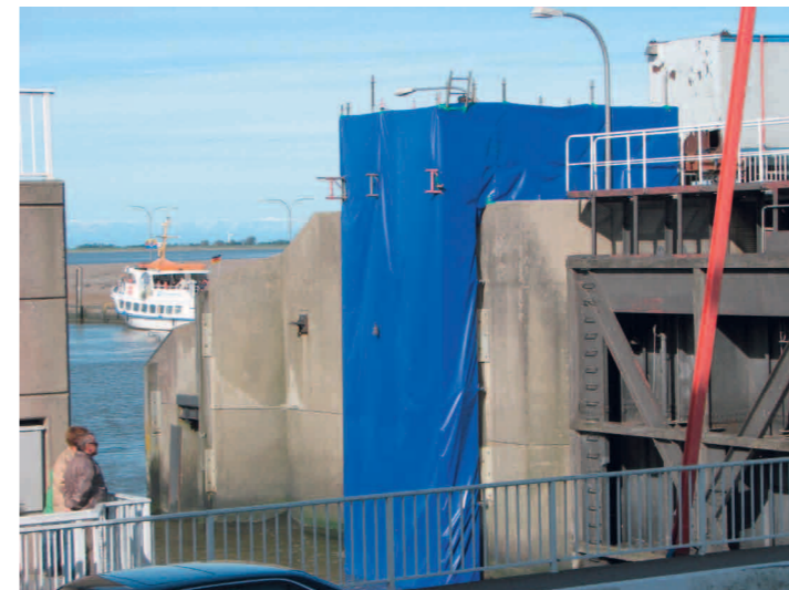
Abb. 3: Gerüst/Einhausung Wendesäule
