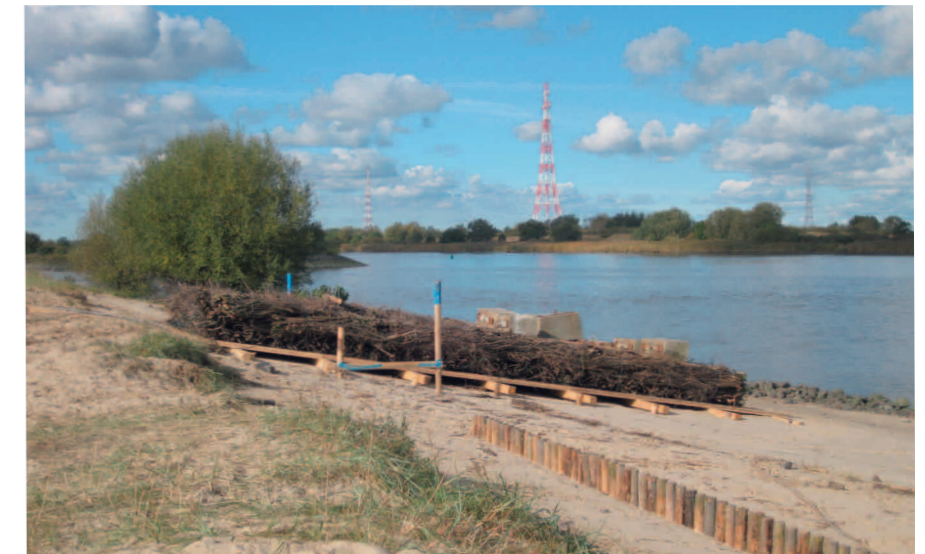
Abb. 5: Faszinenfußsicherung und Helling am Deckwerk Mojenhörn
