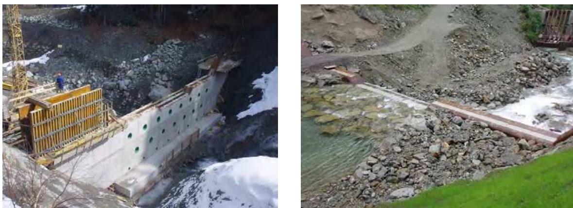
Abbildung 6: Bau bzw. fertiggestellte Konsolidierungssperre mit dem Geophon- und Hydrophonbalken
