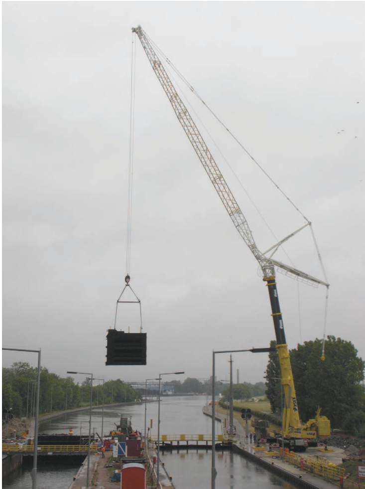
Bild 2: Einheben der Tore am Oberhaupt der Nordkammer
