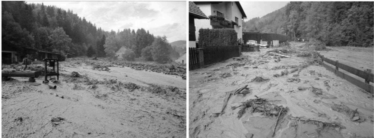
Abbildung 2: Ablagerungen bei Schwemmkegel oberhalb von Oberwölz (linkes Bild), Abfluss über Gemeindestraße (rechts); (WLV in Hübel et al. 2011)
