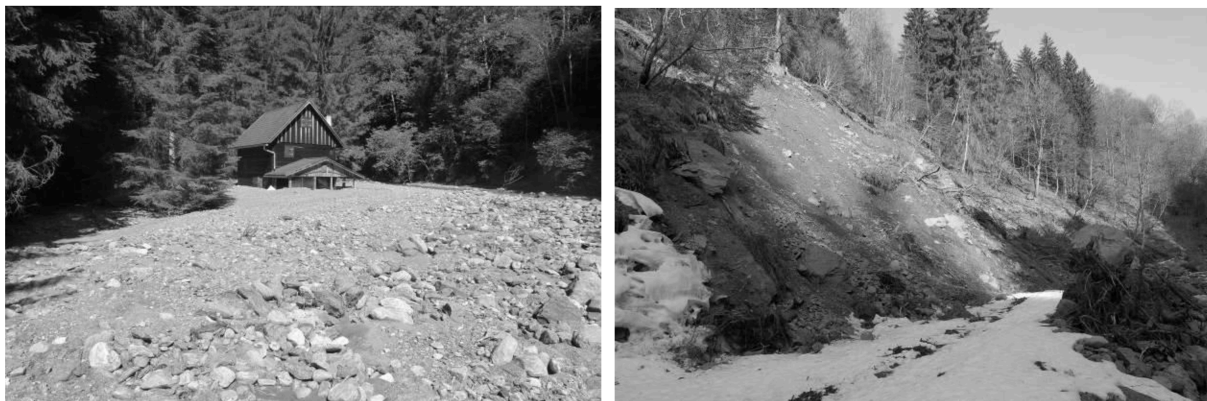
Abbildung 3: Geschiebeablagerungen bei der Mühle oberhalb des Zusammenflusses Schöttlbach und Krumegger Bach (linkes Bild), Böschungsanriss aufgrund rückschreitender Erosion und Tiefenerosion (rechts);
