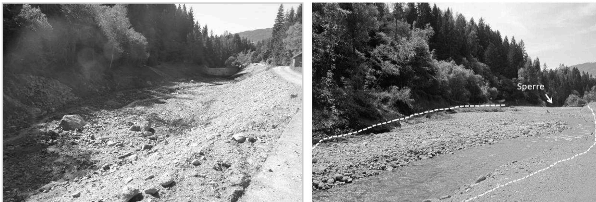
Abbildung 4: Geschieberückhaltebecken im September 2011 (linkes Bild), verlandetes Geschieberückhaltebecken Anfang August 2012 (rechts);
