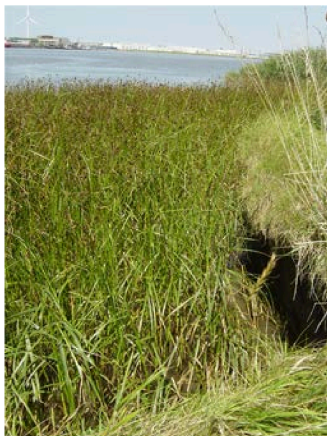
Abb. 5-1: Uferabbruch mit wieder angesiedelter Meer-Strandsimse an der Tegeler Plate
