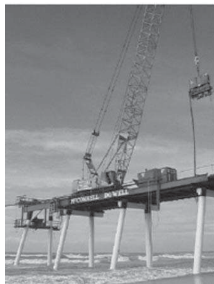
5b) Anordnung der Strahlpumpe an einer Brückenkonstruktion oder über einem Sandfang (Internet)
