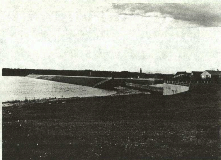
Bild 11: Das Bauwerk mit erneuerter Asphaltbetonaußendichtung
