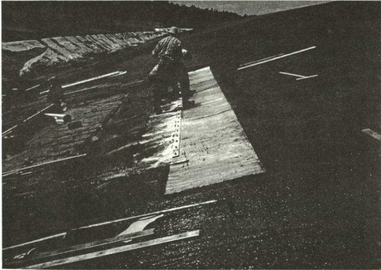
Bild 7: Neuer geklemmter Dichtungsanschluß am Grundablaß
