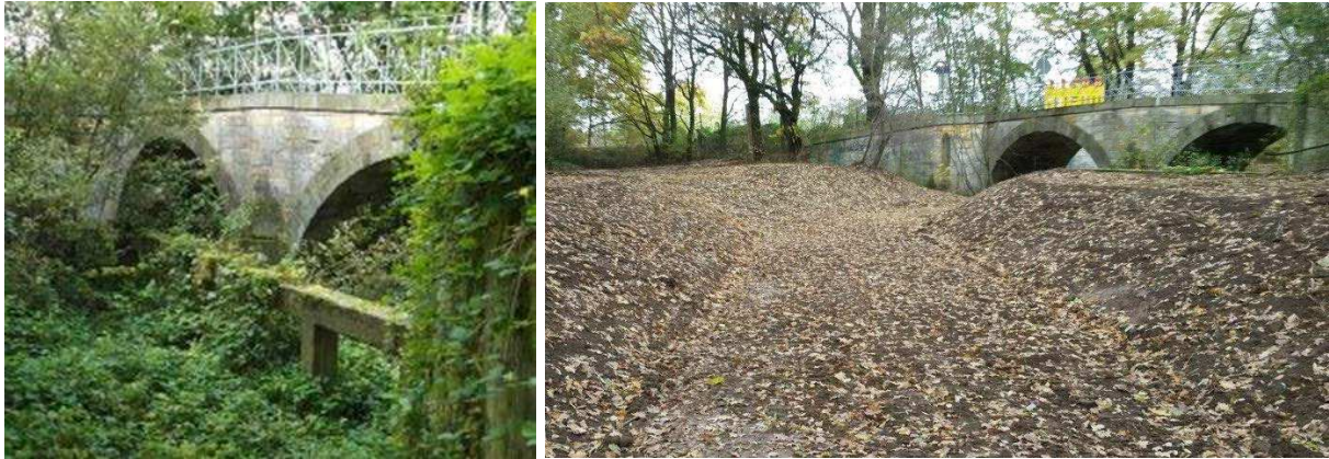
Abbildung 4: HWE Angerflut vor und nach der Ertüchtigung zur Interimslösung für die Gewährleistung der HWE
