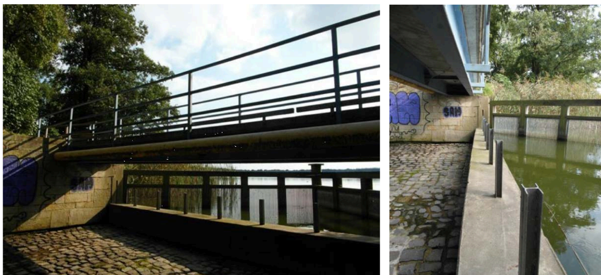
Abbildung 3: HWE Mühlenflut mit vorgelagertem Fischrechen
