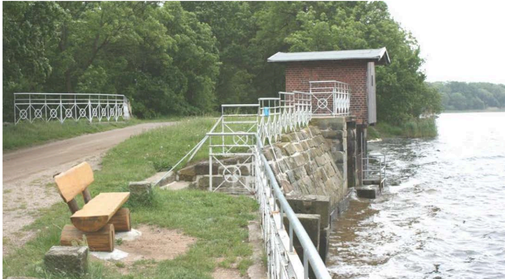
Abbildung 2: Ansicht Wolfsflut mit Ziehhaus und seitlich angrenzender Ufermauer
