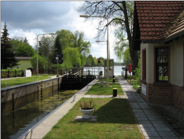
Bild 4: Schleuse Neue Mühle Figure 4: Neue Mühle Lock
