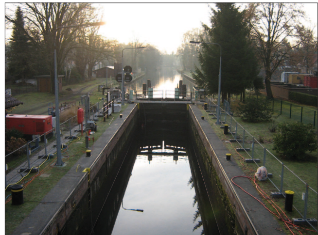
Bild 2: Schleuse Kummersdorf Figure 2: Kummersdorf Lock
