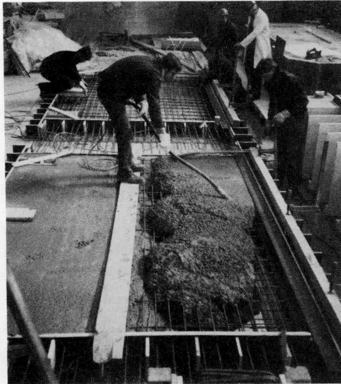
Bild 29: Herstellung der neuen Betriebswegplatten im Fertigteilwerk
