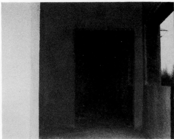
Bild 34: Spritzbetoninstandsetzung in den Arkadengängen im Strombrückenbereich
