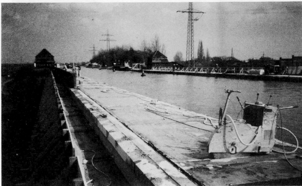
Bild 25: Abbruch der Betriebswegplatten im Strombrückenbereich mit fahrbaren Sägen; daneben das Holzauslegergerüst
