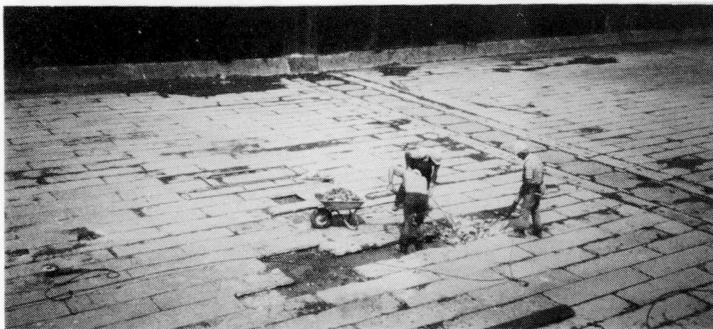
Bild 46: Ausbesserung einiger Betonplatten in der Trogsohle
