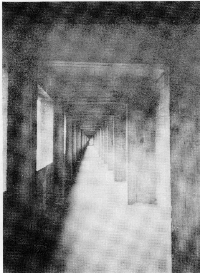
Bild 19: Arkadengänge im Strombrückenbereich mit der Stahlbetonrahmenkonstruktion; links: Fenster, rechts: Trogwand
