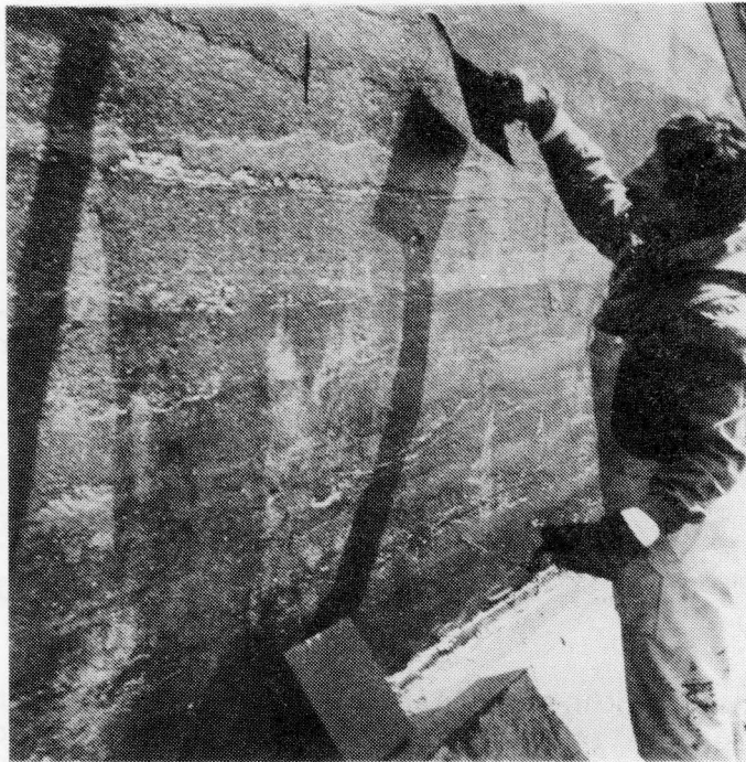
Bild 51: Aufbringen der neuen Wandbeschichtung; hier: Grundierte Wandflächen und Auftragen der Kratzspachtelung
