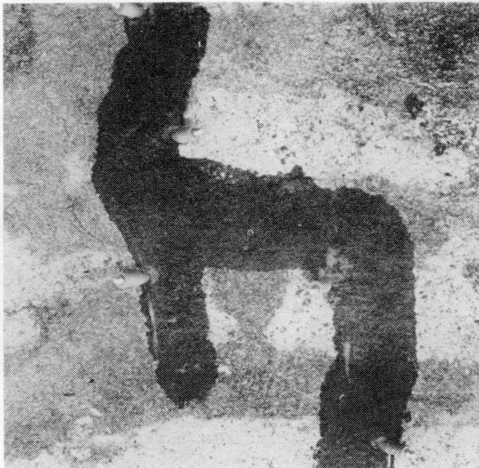
Bild 50: Detail; eingebohrte Packer zur Rißverpressung
