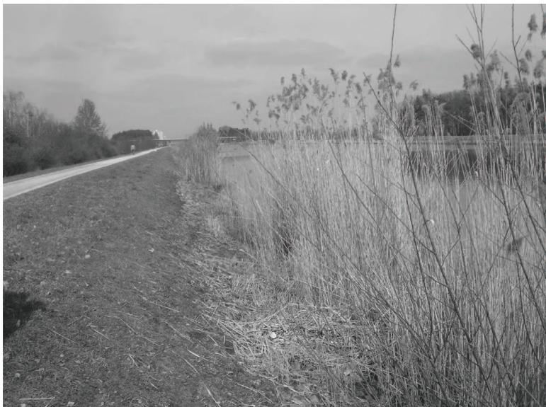
*Bild 7: Bewuchs einer Asphaltdichtung*
