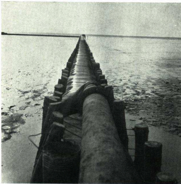
Abb. 7. Füllen eines Kunststoffgewebeschlaches als Lahnung
