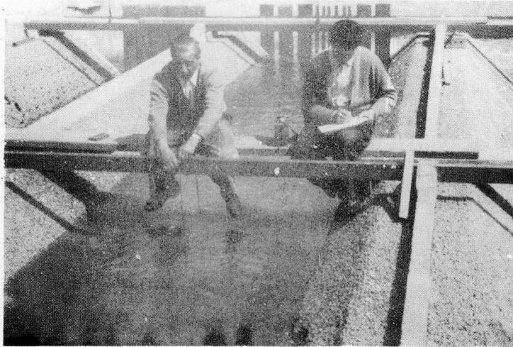
**Bild 4** Die Durchführung der Flügelmessungen
