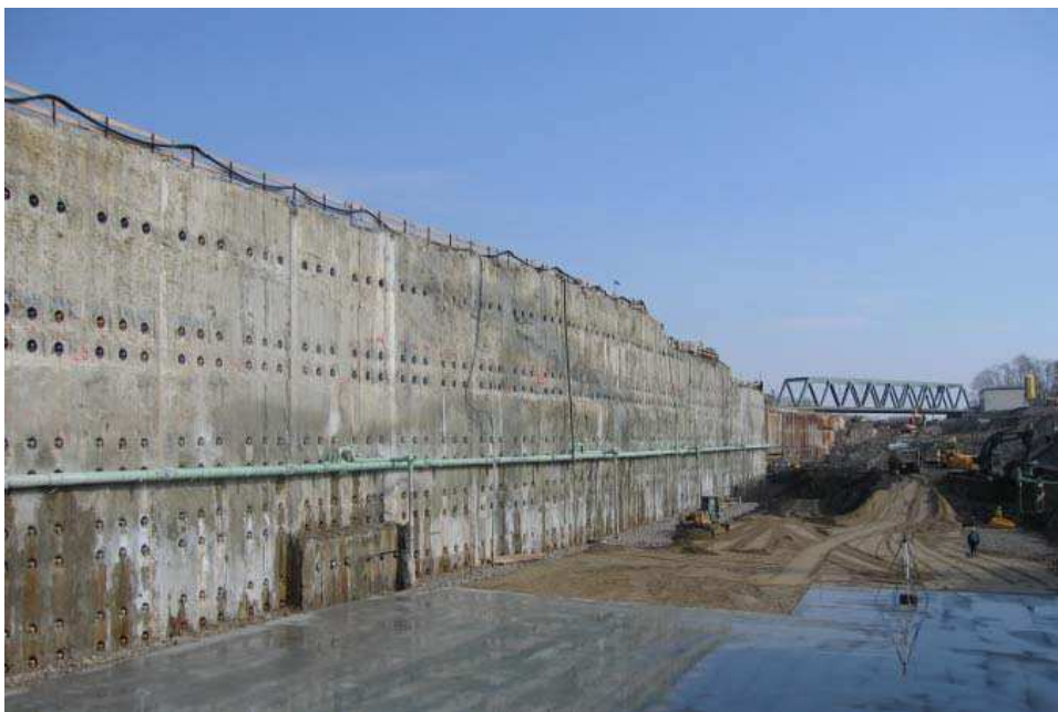
Bild 5: Rückverankerte Schlitzwand der Baugrube für die Südschleuse Sülfeld
