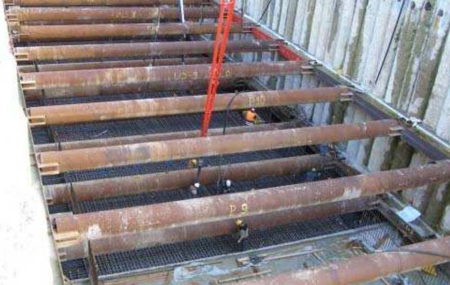
Bild 8: Aussteifung der Bohrfahlwand der Schleusenbaugrube Bolzum im Sohlbereich.
