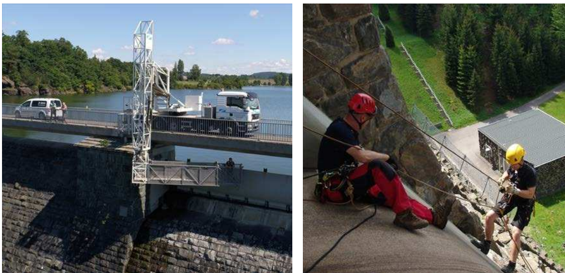
Abbildung 1: Technische Prüfung über Wasser / luftseitig mittels Brückenuntersichtgerät und alpiner Höhensicherungstechnik.
