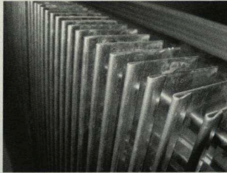
Abbildung 1 Ansicht der Oberkante des Oppermann-Rechens
