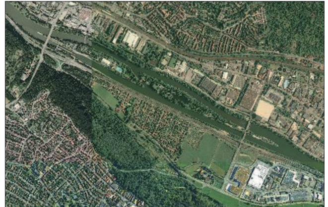
Bild 3: Mehrachsige Staustufe Figure 3: Multi-axis barrage
