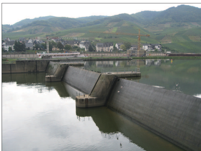
Bild 2: Die Moselstaustufe Fankel mit Kraftwerk, dreifeldrigem Sektorwehr und Schleusenkammer Figure 2: The Moselle barrage Fankel with power plant, weir consisting of three sector gates and ship lock
