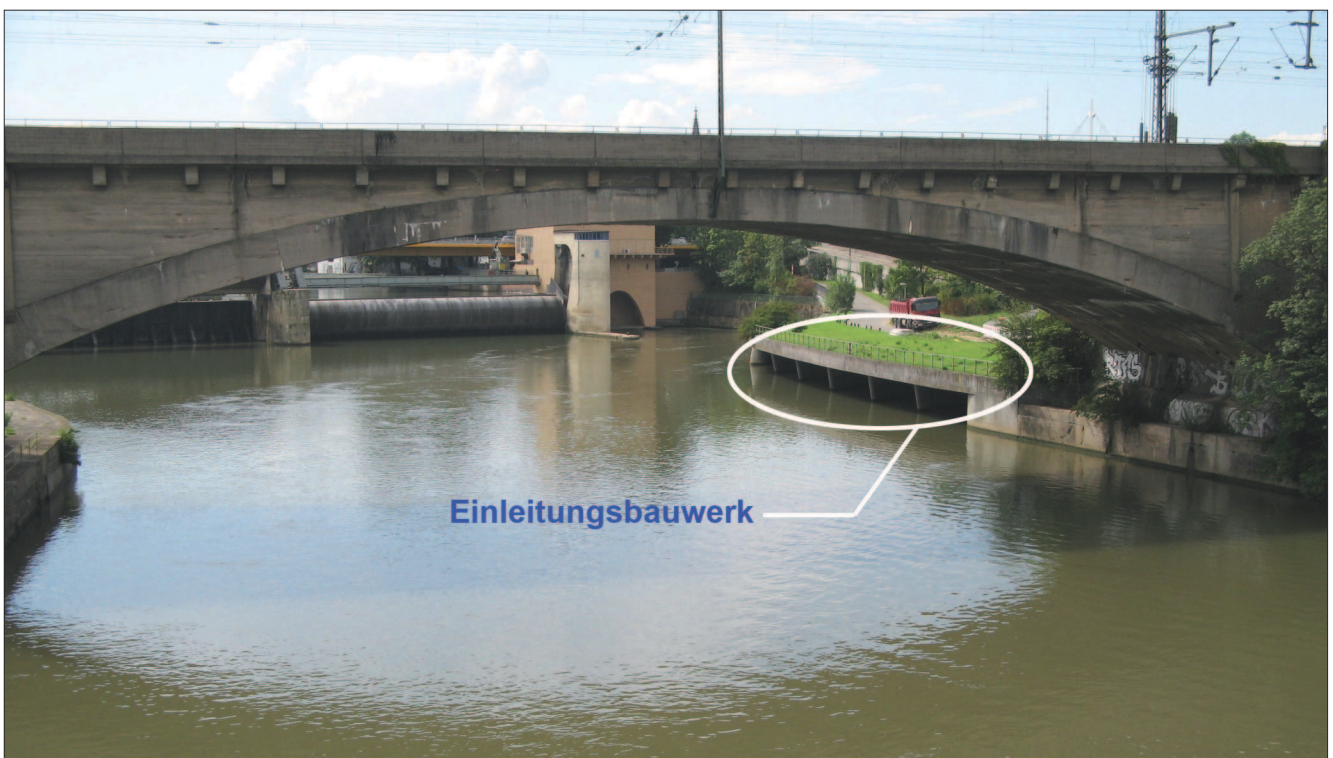
Bild 4: Unterwasser des Wehres Cannstatt mit Einleitungsbauwerk des RÜB Schwanenplatz
