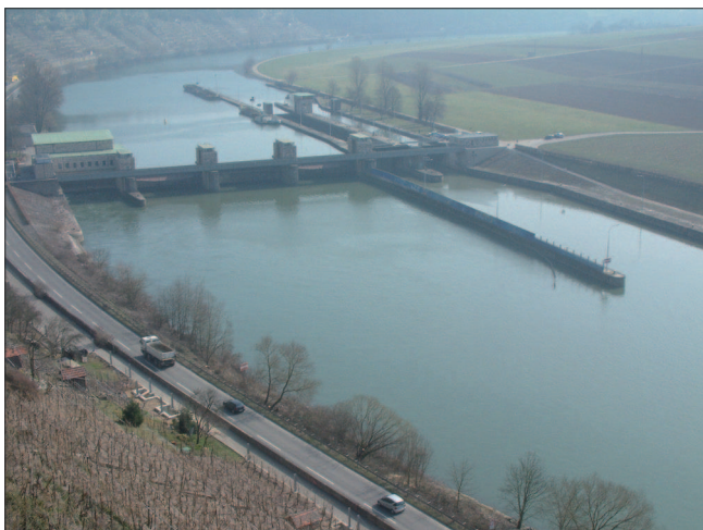
Bild 1: Stauregelung mit Kraftwerk, Wehr und Schleuse Figure 1: Water level control with power plant, weir and lock
