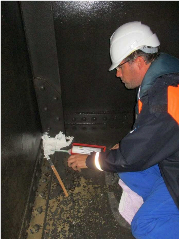
Bild 5: Verstreichen einer Epoxidharzbeschichtung aus einer Doppelkartusche mit einem Pinsel (Bartlänge mit einer Schere auf 2 cm gekürzt)
