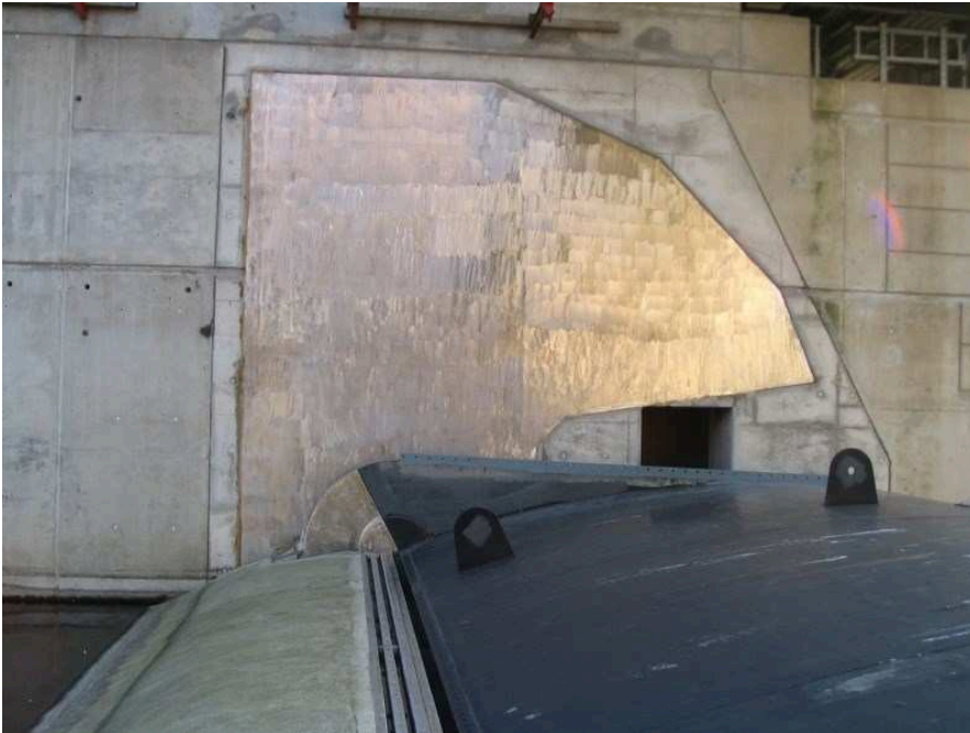
Bild 1: Großzügige Edelstahlschleiffläche der Seitendichtung an einem Wehr
