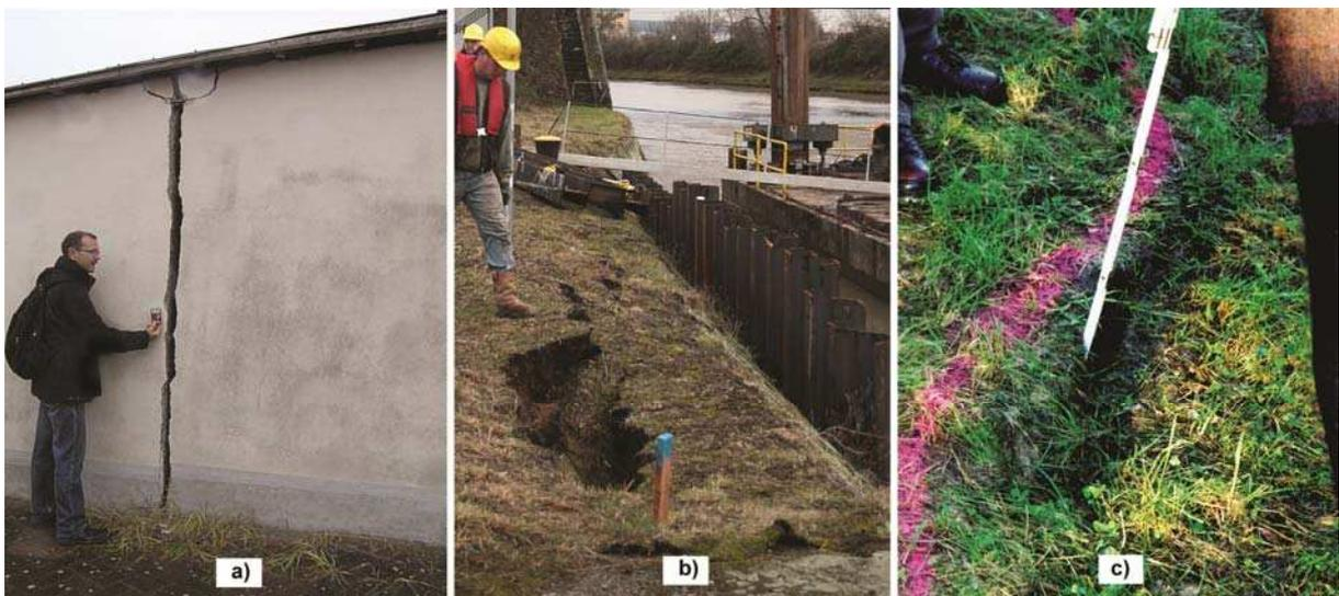
Bild 6: Auswirkungen von Vibrationsrammungen auf Baugrund und Bauwerke a) Bauwerksriss durch ungleichmäßige Setzungen, b) Einbrüche im Uferbereich, c) Böschungsabriss im Kanalseitendamm (Zerrenthin, 2012)
