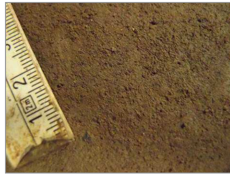
Abbildung 12: intakte Flüssigboden-Struktur nach erster Aufgrabung
