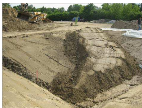
Abbildung 3: Abdeckung der Flüssigbodendichtung 05/2011
