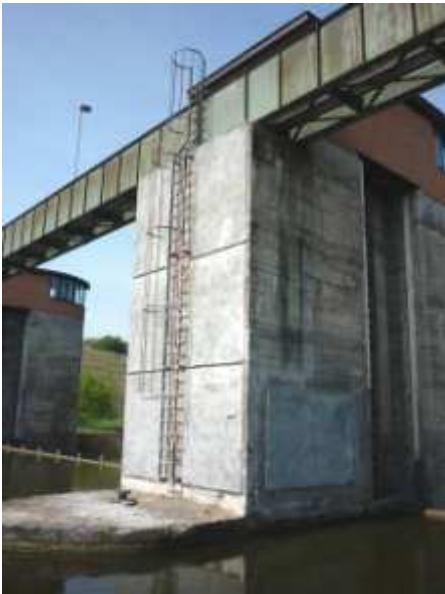
Bild 15: Durchgeführte Probeinstandsetzung nach dem ersten Winter
