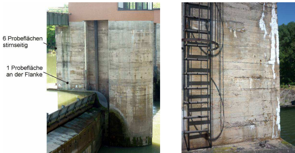
Bild 7: Wehrpfeiler 3 des Wehrs Horkheim. Links: Ansicht der Flanke. Rechts: Ausschnitt Stirnseite (aus /Orlowsky 2011/)
