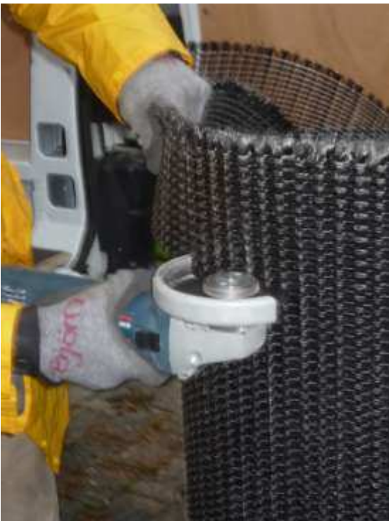
Bild B42: Zuschnitt der Textilien vor Ort mit einer Flex
