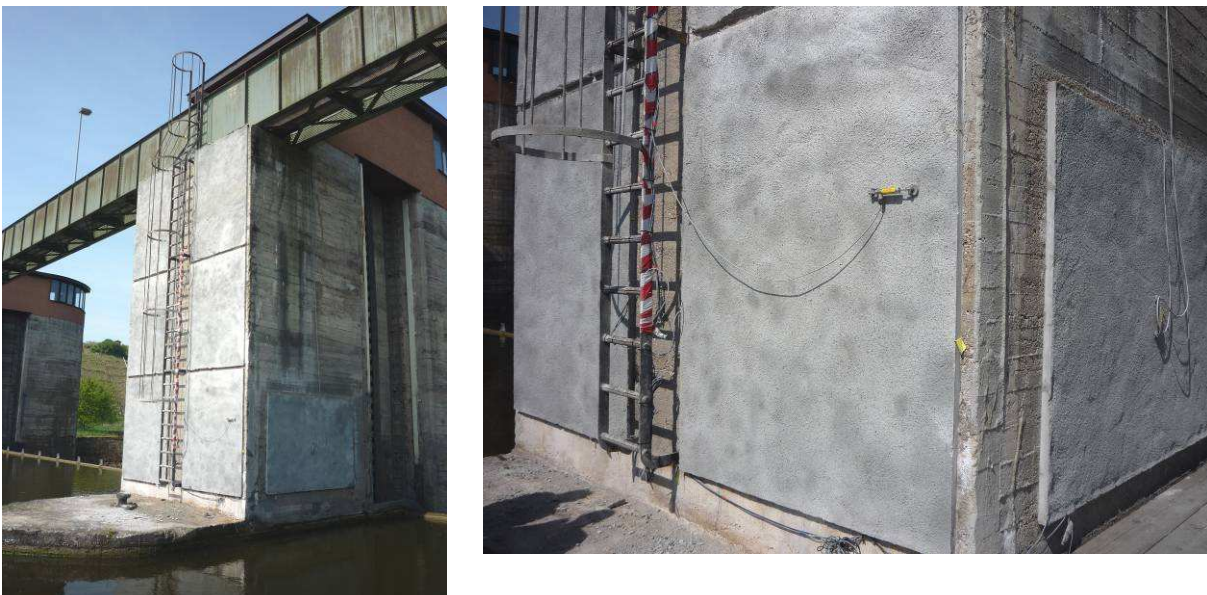
Bild 9: Durchgeführte Probeinstandsetzung nach dem ersten Winter (aus /Orlowsky 2011/)
