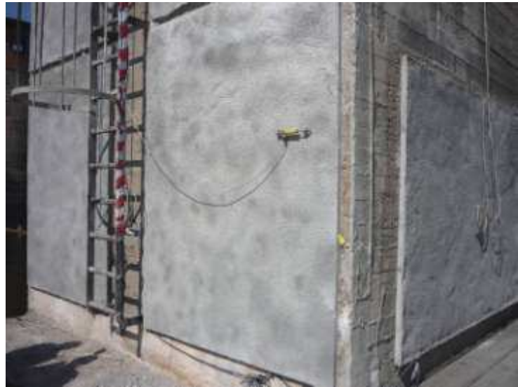
Bild 15: Durchgeführte Probeinstandsetzung nach dem ersten Winter
