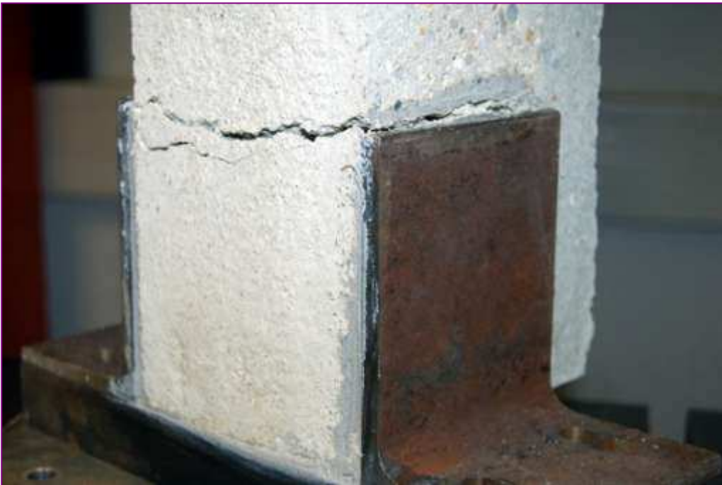
Bild B19: Versagen des Altbetons beim Rissüberbrückungsversuch bei etwa 12 kN
