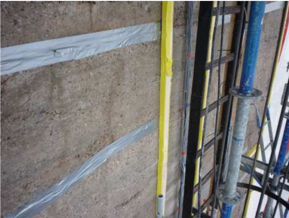
Bild B41: Lokale Untergrundbehandlung im Bereich der Arbeitsfugen
