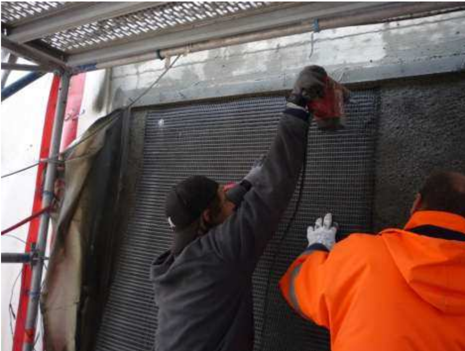
Bild B44: Befestigung der Textilien mittels Glasfaserdübel und Edelstahltellern
