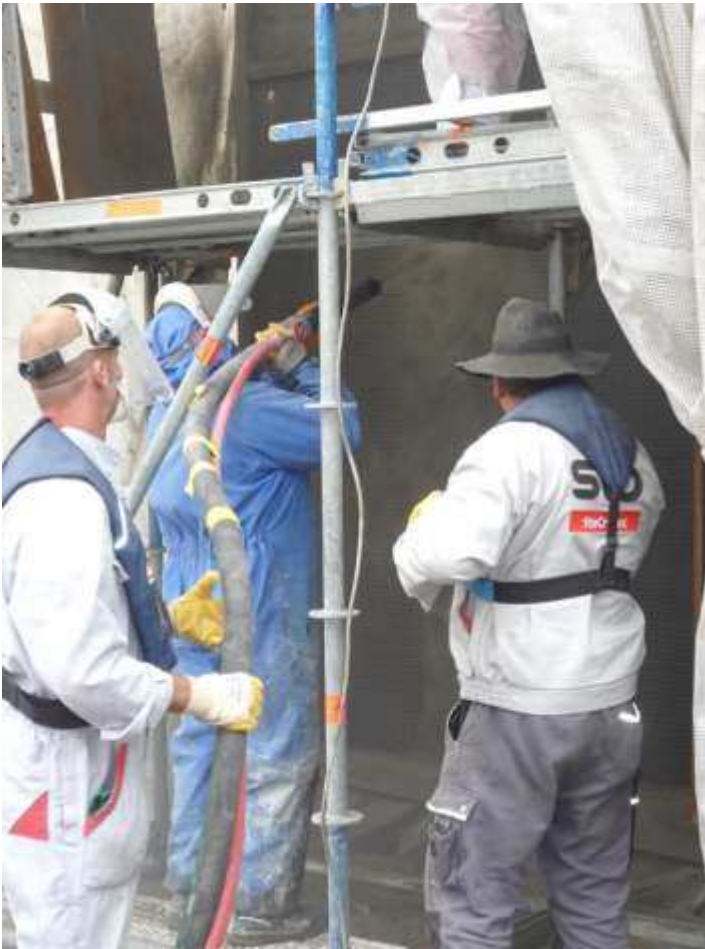
Bild B45: Einbettung des Textils mittels Spritzmörtel
