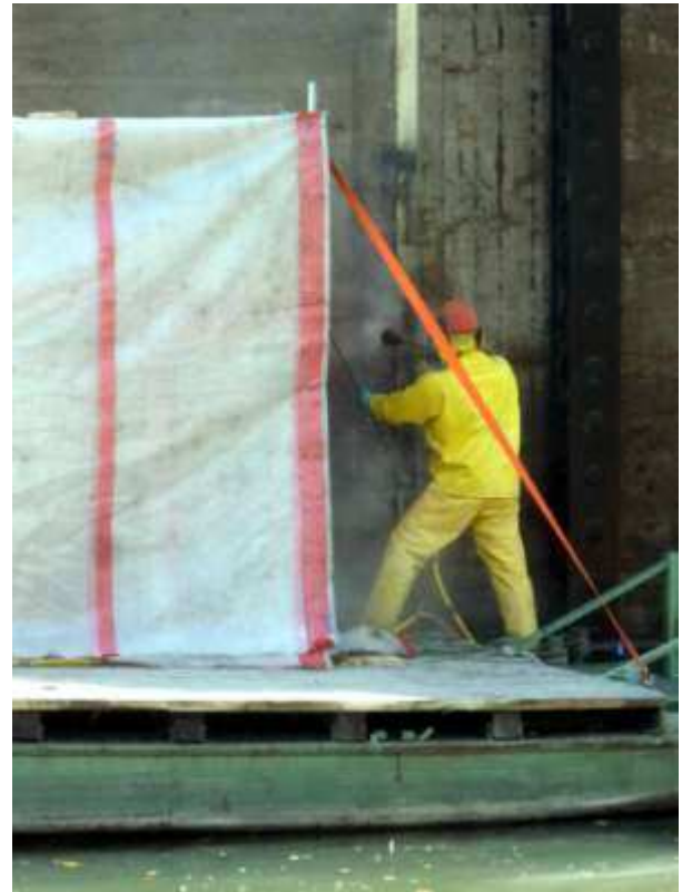
Bild B39: Flanke von Pfeiler 3 (Probefläche 7) und Betonvorbereitung durch Höchstdruckwasserstrahlen
