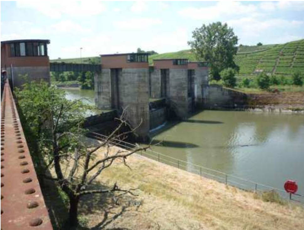
Bild B37 : Gesamtansicht des Wehrs Horkheim
