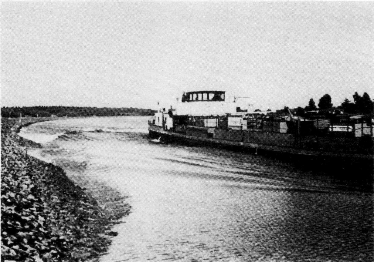
Bild 1 Wasserspiegelabsenk und Wellen an schiffbaren Wasserstraßen
