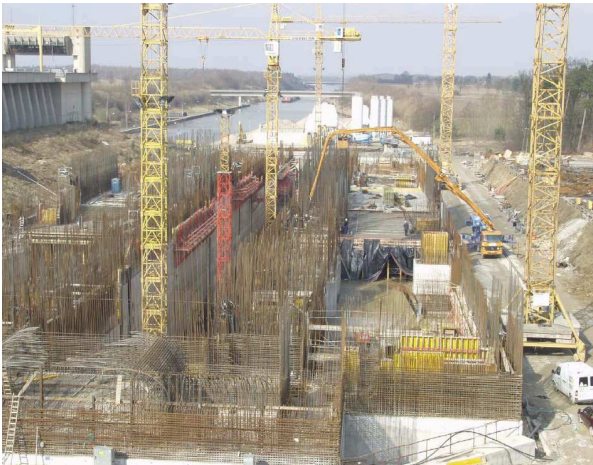
Bild 5: Bewehrungsarbeiten
