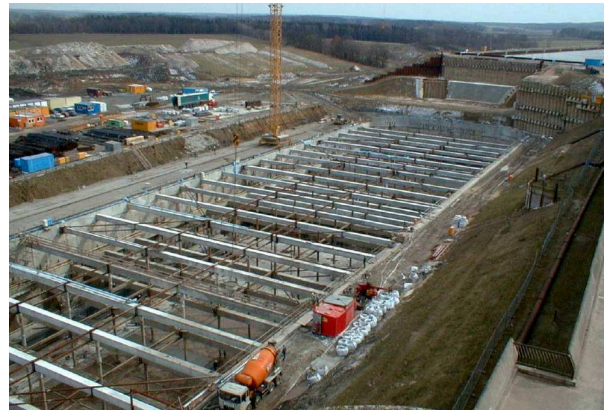
Bild 9: Baugrubenverbau
