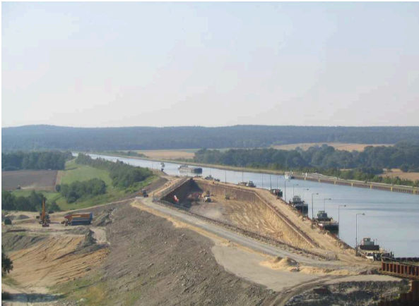
Bild 10: Oberer Vorhafen, Dammstrecke
