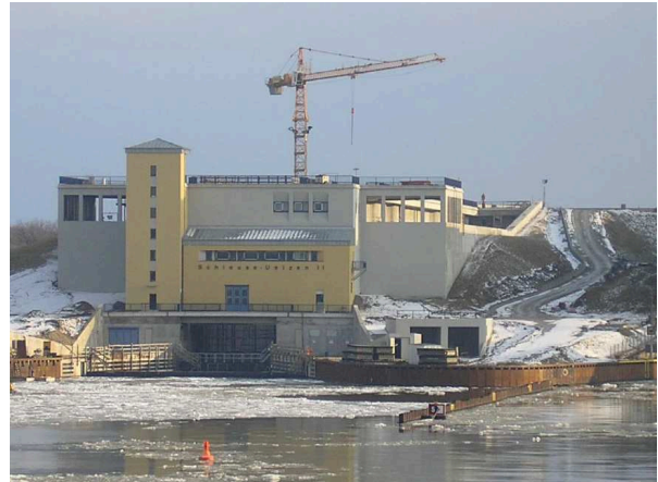
Bild 12: Schleusenansicht kurz vor Inbetriebnahme
