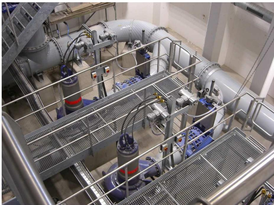
**Abbildung 5:** Maschinenkeller mit trocken aufgestellten Tauchmotorpumpen
