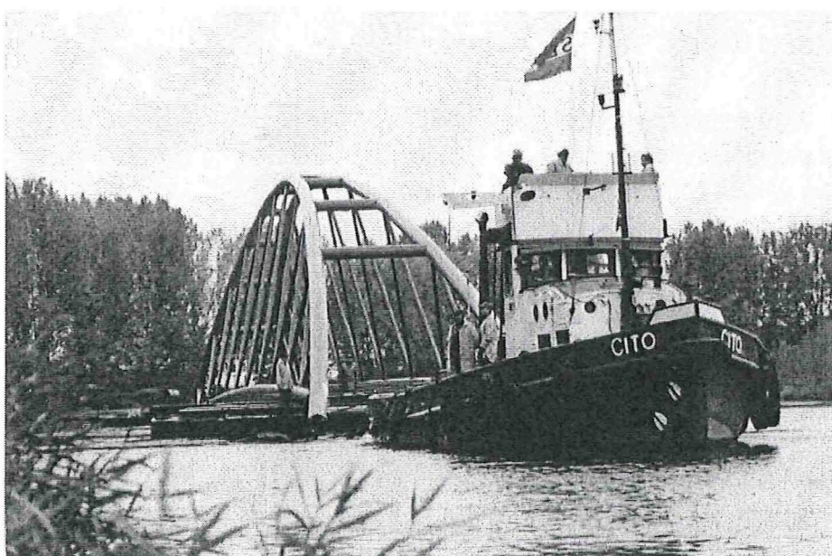
Bild 3: Transport des Bogentragwerkes
