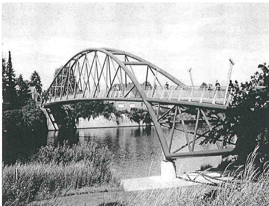
Bild 2: Blick von den Wallanlagen der historischen Altstadt auf die neue Rad- und Fußwegbrücke
