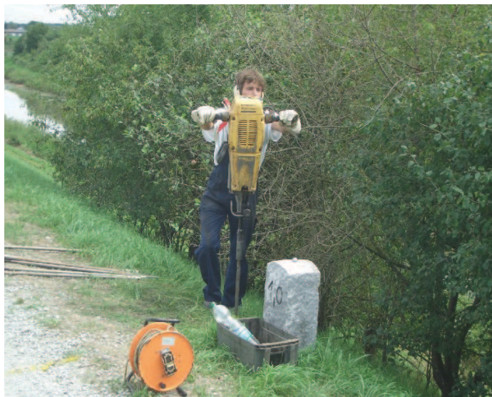
Bild 4: Einbau der Sondiergestänge
