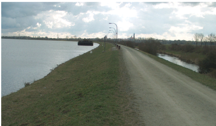
Bild 1: Rechter Donauseitendamm, km 2331,650, Blick in Richtung Staustufe, links Donau, rechts Laberableiter
